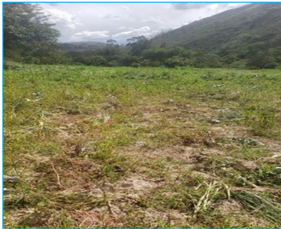
Fotografía 01. Limpieza de terreno
