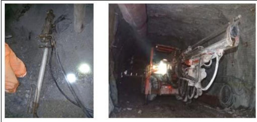
Figura 01. Equipos de perforación
