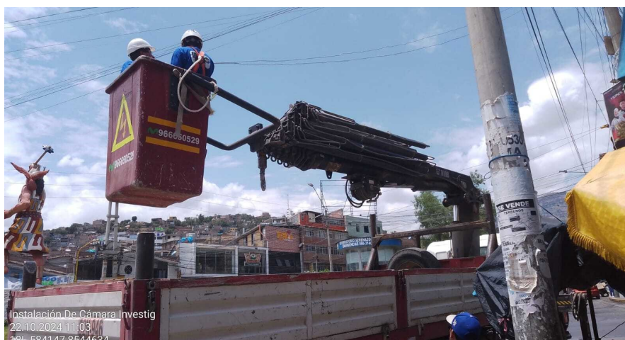
Figura 267: Instalación de las cámaras de investigación Fuente: Imagen propia
