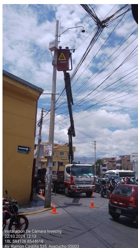
Figura 273: Montaje del brazo rígido de soporte Fuente: Imagen propia
