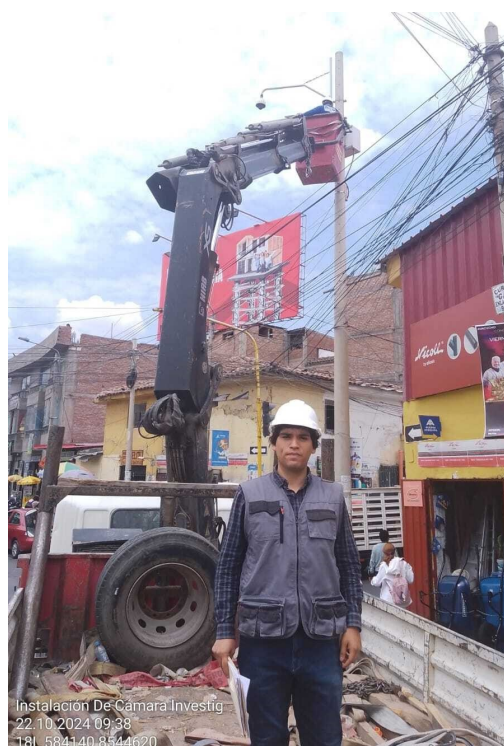
Figura 271: Supervisión de la instalación. Fuente: Imagen propia
