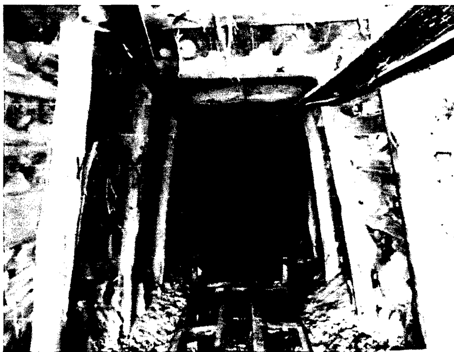
FOTOGRAFIA N° 04 : Cuadro de 3 elementos en una sección de 7' x 8'
