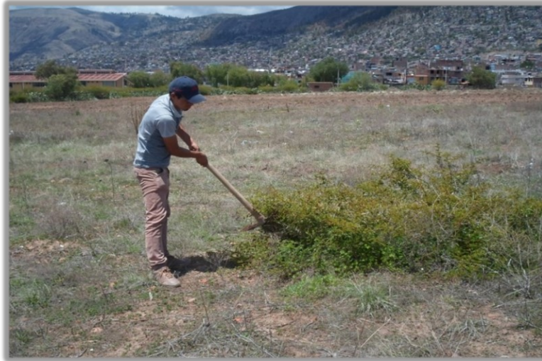
Figura 2 Trazo y replanteo del terreno
