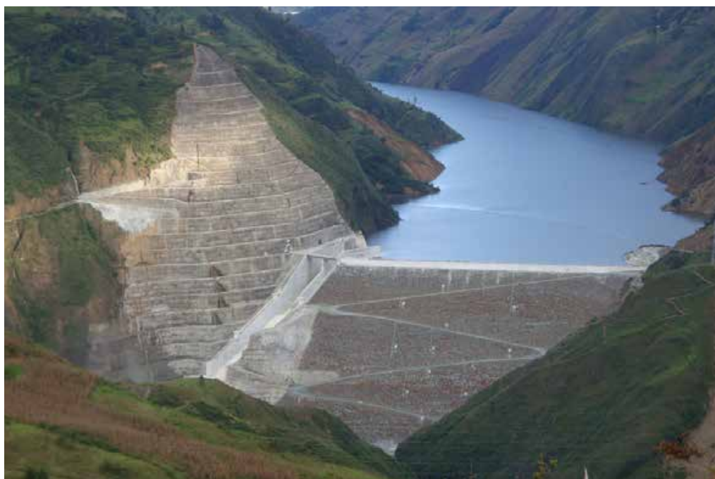
Figura 4 Aliviadero en una presa de enrocado.
