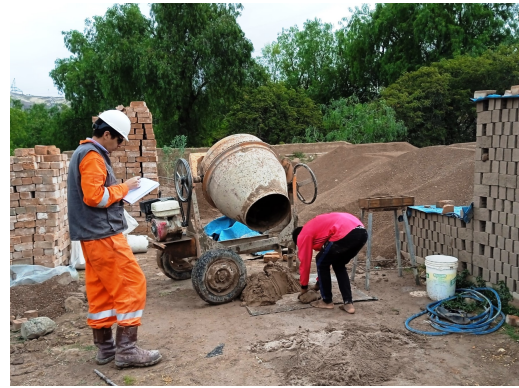
(b) Moldeado de ladrillos
