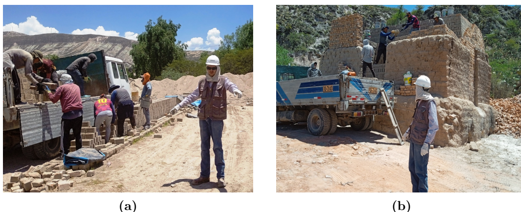
Figura 3.11: Traslado de ladrillos crudos al horno.
