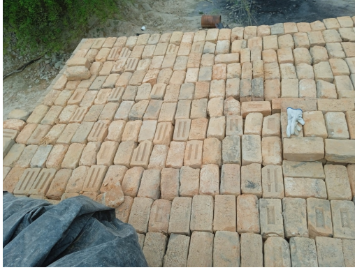
(a) Antes de la quema: techo del horno nivelado.
