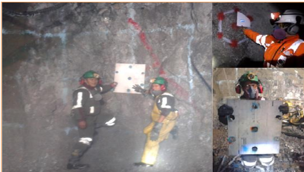
Fig. N° 104: Implementación de la plantilla para el arranque
