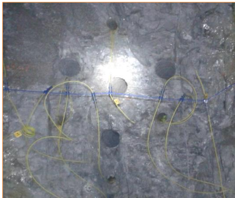
Fig. N° 86: Arranque realizado en la Mina Santander
