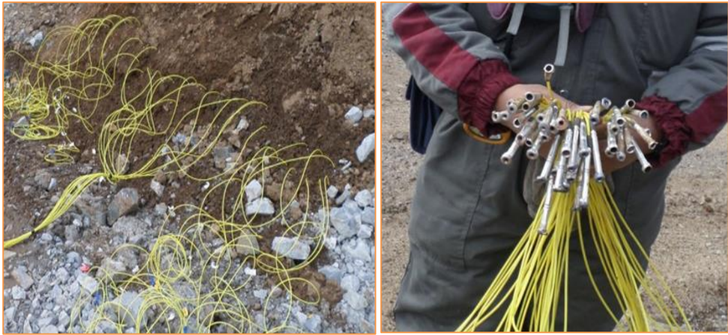
Fig. N° 103: Pruebas de detonación en vacío BM Magistral Norte Nv 4650
