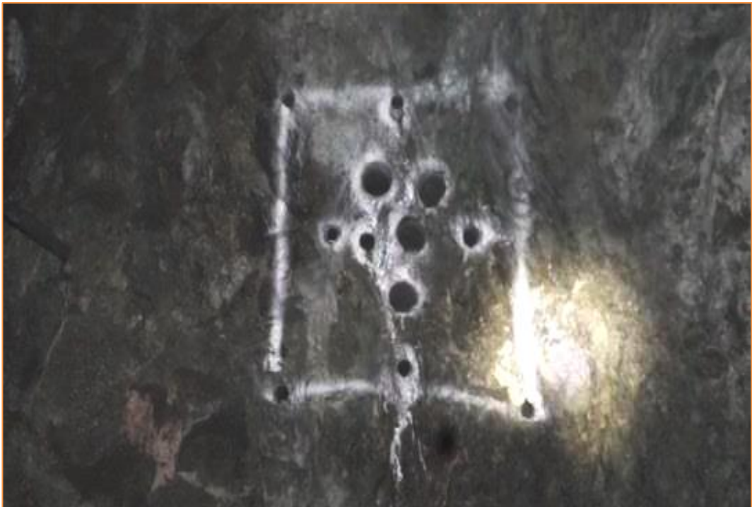
Fig. N° 69: Arranque perforado en la RP (-) 4370 - 4 Magistral Centro
