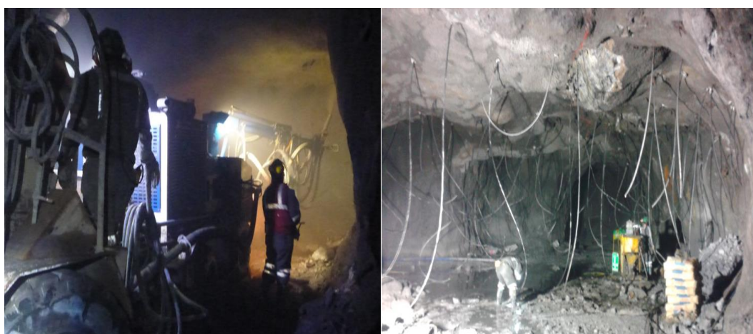
Fig. N° 24: Sostenimiento con shotcrete (Izquierdo) y con cable bolting (derecha)
