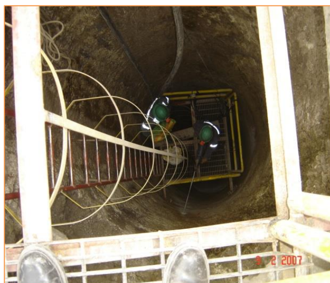
Fig. N° 13: Implementación de escaleras e instalación de servicios - Mina Santander
