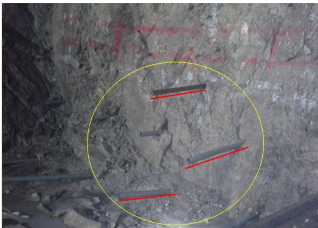
Fig. N° 105: Estandarización y uso de guidores en las labores de avance
