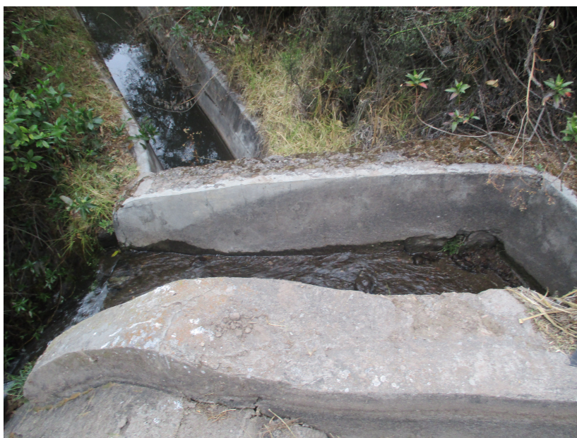
Figura 3.17: Estructuras hidráulicas existentes
