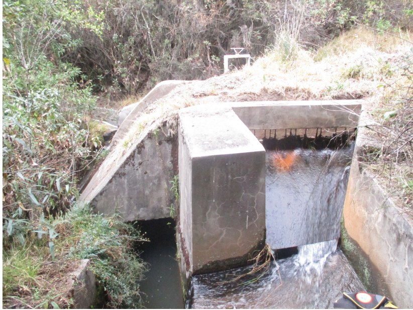
Figura 3.18: Captación sobre la quebrada Mutuy huayqo
