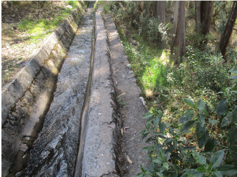
Figura 3.19: Estado actual de los canales existentes
