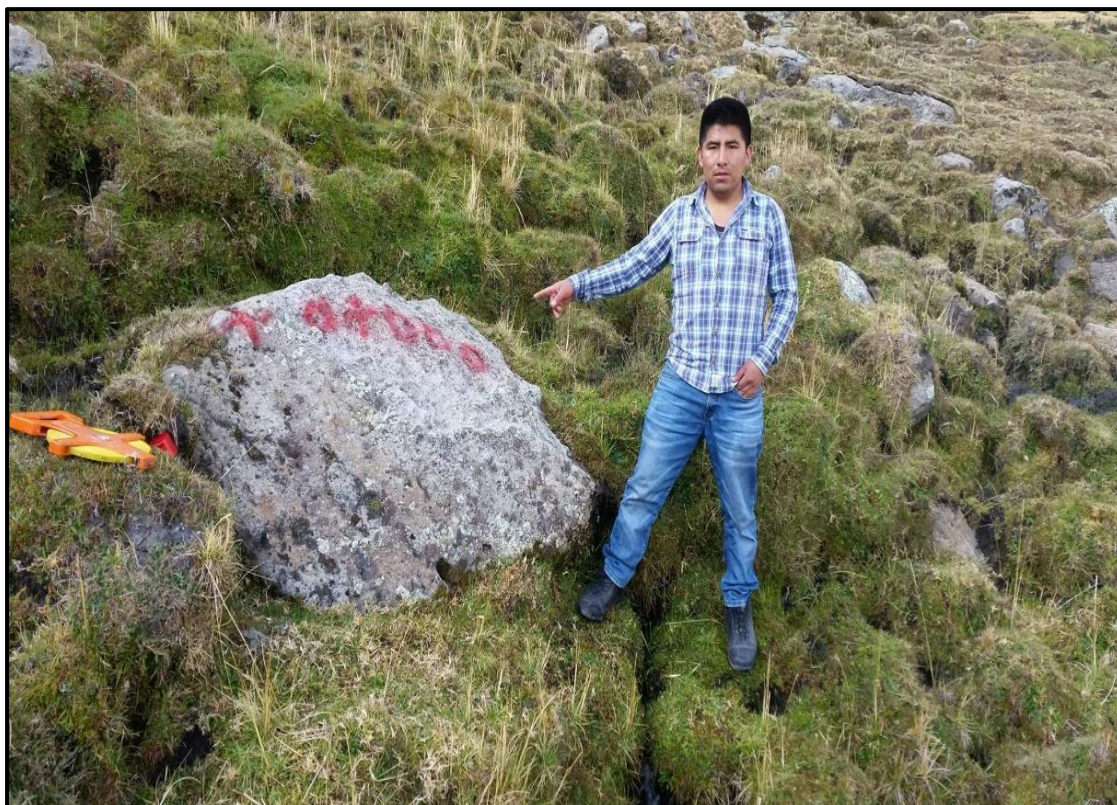
Fotografía 7. Inicio de la línea conducción, para tal caso se realiza el respectivo marcado de las progresivas, empezando de 0+000 KM ubicado en la captación.
