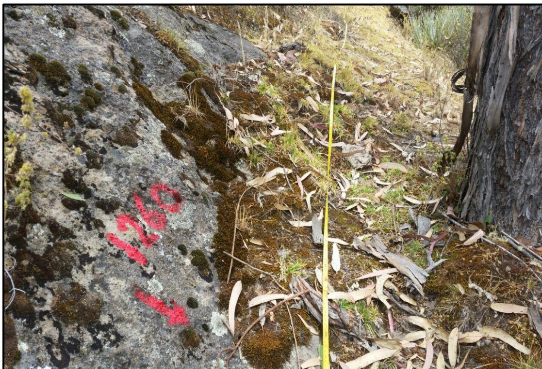
Fotografía 8. Pintado y marcado de las progresivas de la línea de conducción de sistema de riego presurizado, resaltando con esmalte rojo en rocas fijas.
