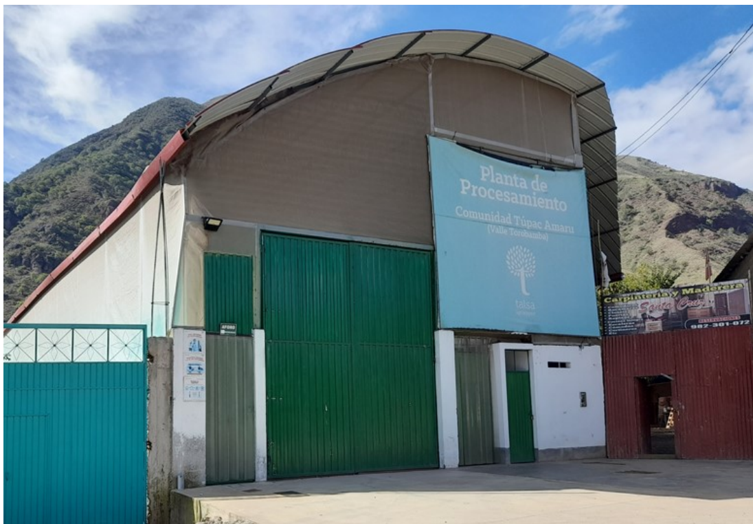
Foto 13. Instalaciones de almacén de acopio de palta Hass de la empresa TALSA AGROEXPORT S.A.C. acopiador de exportación en el centro poblado de Patibamba del valle de Torobamba
