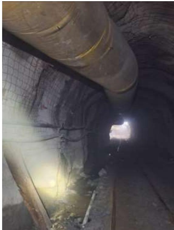
Figura 18: Sostenimiento con pernos Helicohidales y malla electrosoldada
