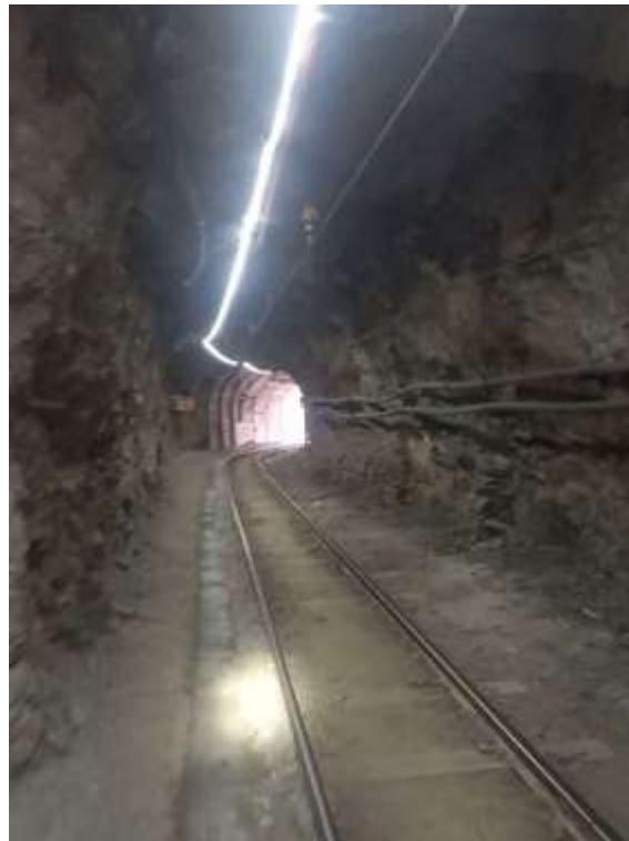
Anexo 10: Salida de la Mina Paraíso Nv 1467
