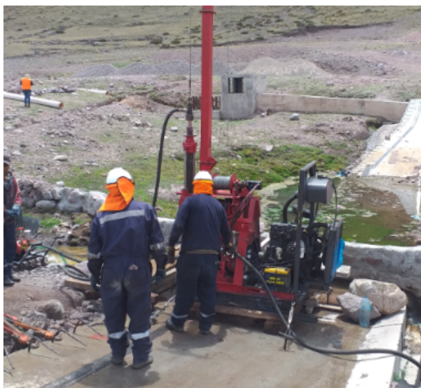
Figura C.36 Perforistas encargados de realizar los trabajos de perforación diamantina. Fuente: Elaboración propia
