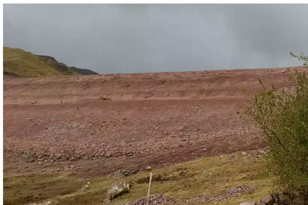
Figura C.29 vista de la presa en el talud aguas abajo. Fuente: Elaboración propia
