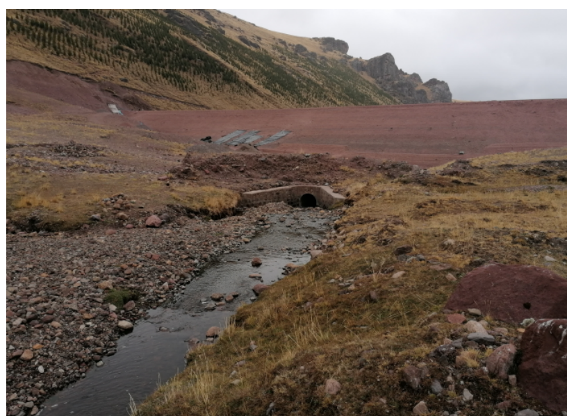
FIGURA 2.2 Vista panorámica de la presa con el dique actual.
