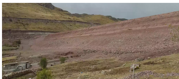
Figura C.30 vista de la presa en el talud aguas abajo. Fuente: Elaboración propia
