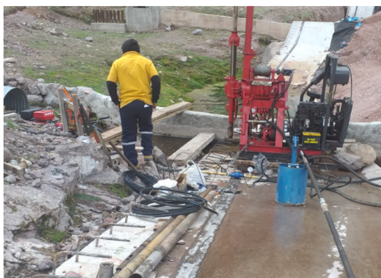
Figura C.38 Equipo de instalación para la prueba Lugeon. Fuente: Elaboración propia
