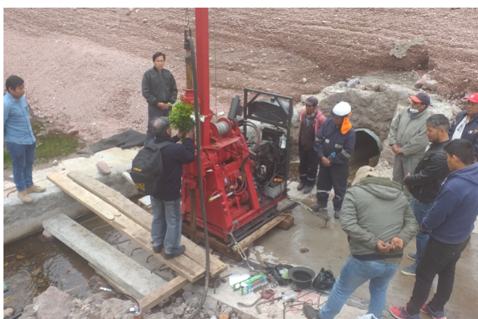
Figura C.34 Inicio de los trabajos de perforación dimantina. Fuente: Elaboración propia
