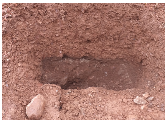
Figura C.32 Calicatas realizada en el talud aguas arriba de la presas. Fuente: Elaboración propia
