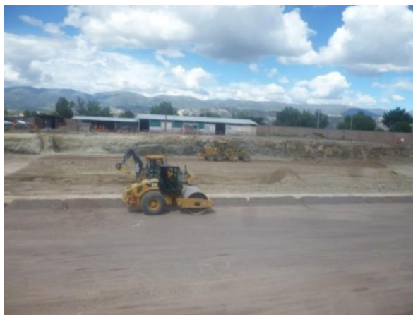
Figura 7: Mejoramiento de terreno a través de las estabilización mecánica en la Obra: " Mejoramiento de la capacidad resolutive del hospital regional Miguel Ángel Mariscal Llerena"
