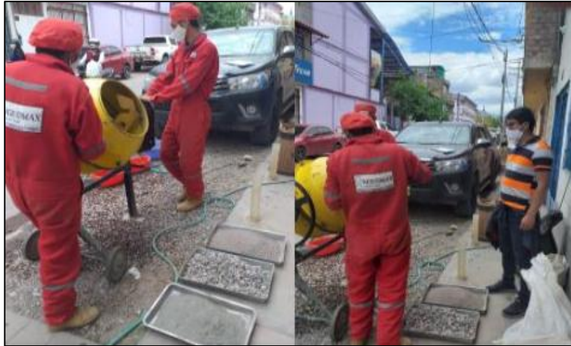
Figura 2.13. Selección de agregado grueso reciclado
