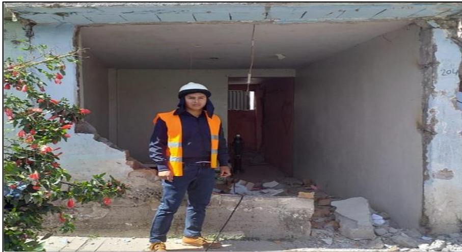
Figura 2.4. Imagen de la vivienda N° 3
