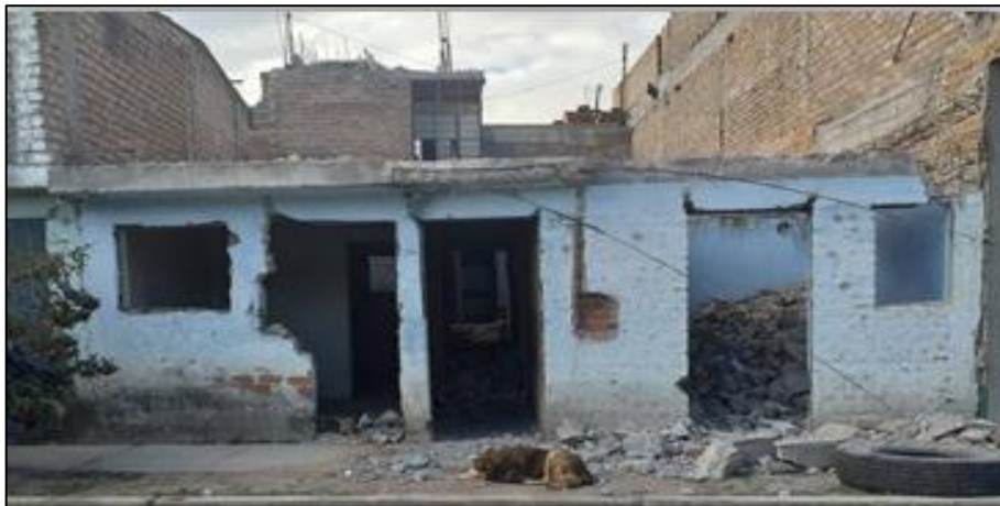
Figura 2.2. Imagen de la vivienda - N° 1
