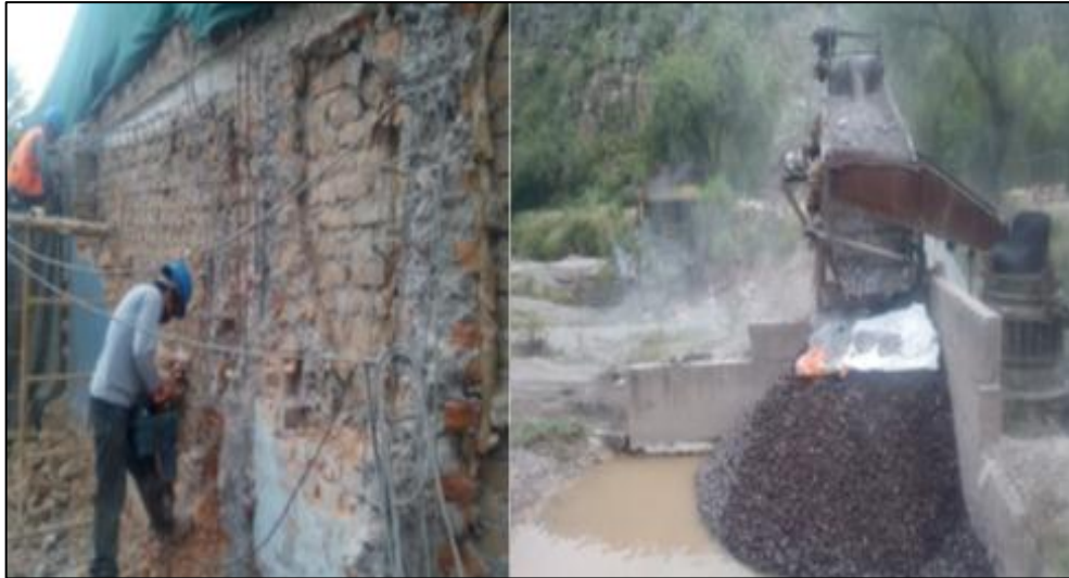
Figura 2.10. Demolición de vivienda
