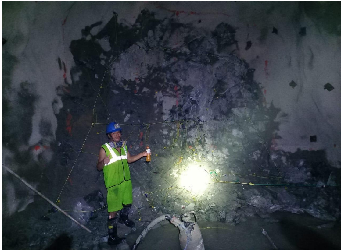
Amarre de Faneles a Pentacord y a Carmex en la Rp 2800
