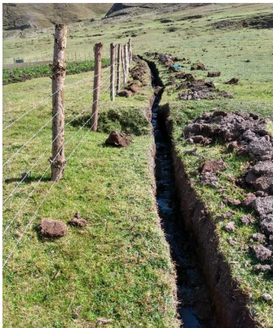
Anexo 4. Zanjas de drenaje en el humedal de Rodeopampa (derecha) y Ranraqocha (izquierda).
