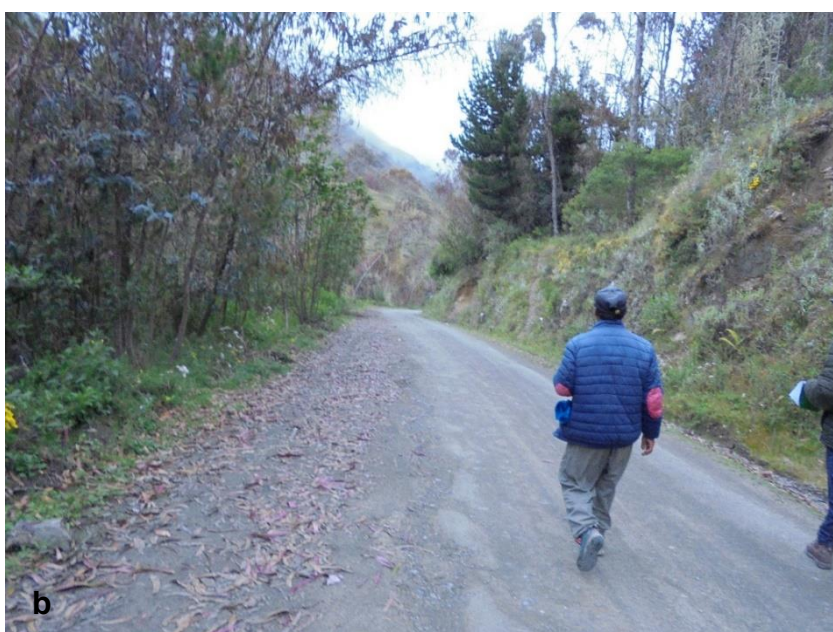
Figura 8. Tramos de carretera de pendiente favorable al drenaje
