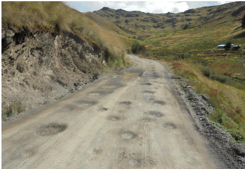
Figura 15. Baches en superficie de pendiente nula en el tramo Cunya - Huaychao
