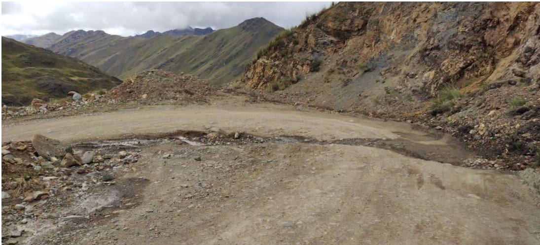
Figura 17. Típica deformación de la curva de volteo
