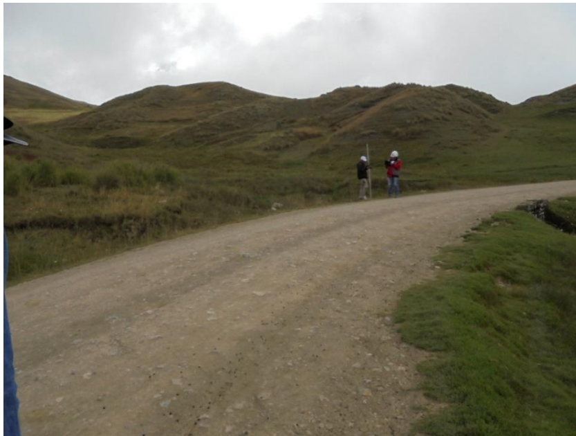
Figura 10. Curva con ahuellamiento suavizado por recompactación tramo Uchuraccay - Cunya
