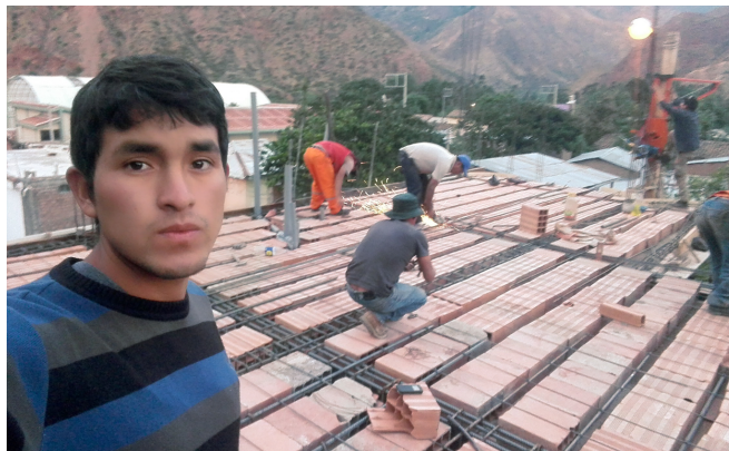
Figura 2.21: Distribución y armado de losa aligerada con ladrillo de arcilla provincia de Cangallo- Ayacucho
