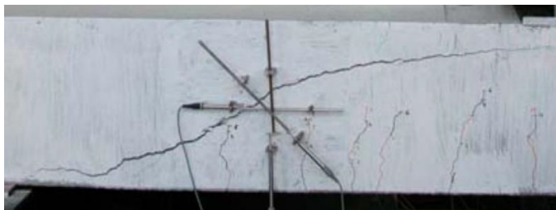
Figura 2.8: Ruptura por cortante en losa maciza
