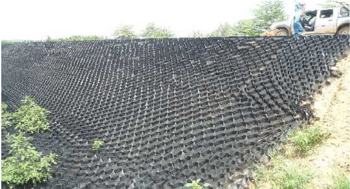
Figura 6.2: Ubicación de zonas de rotura de la geocelda en talud del rio Tumbes.
