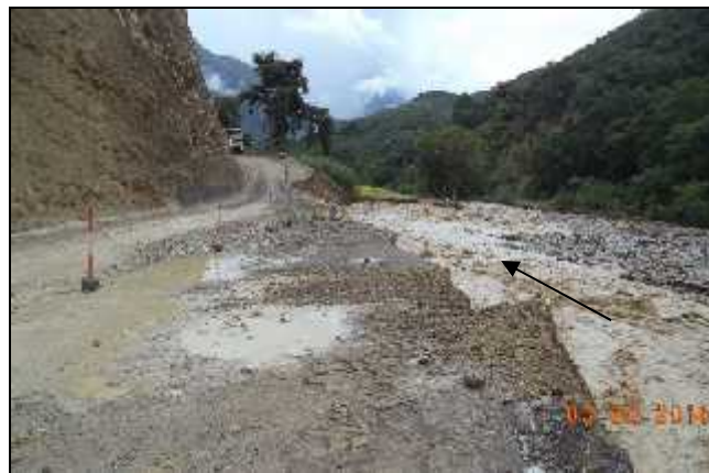
Figura 6.65: Erosión de la margen izquierda del río Callayuc en el tercer tramo.
