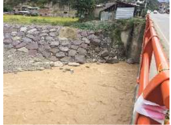
Figura 6.74: Falla del enrocado de protección del estribo izquierdo del puente Callayuc.
