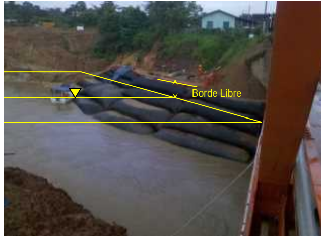
Figura 5.5: Apilamiento de tubos geotextiles y borde libre para contener el máximo tirante.
