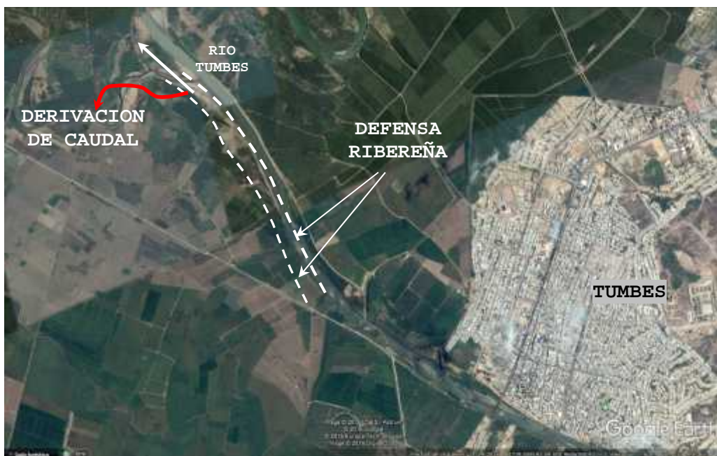
Figura 6.1: Ubicación de la defensa ribereña en ambas margenes del río Tumbes.
