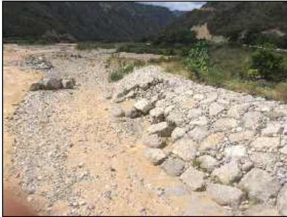
Figura 6.74: Falla del enrocado de protección del estribo izquierdo del puente Callayuc.
