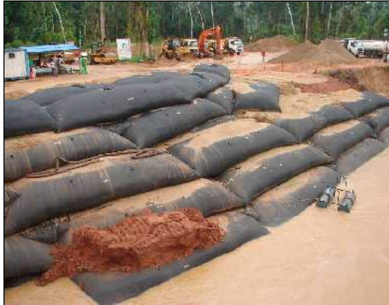
Figura 6.6: Apilamiento de tubos geotextiles.
