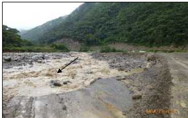
Figura 6.69: Incidencia de la línea del thalweg en el 5° tramo.
