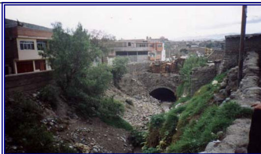
Puente Nuevo en donde existe un estrangulamiento del cauce del río Alameda con probabilidad de desbordes
