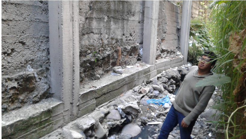
Figura 4.0.3: Aquí se observa un pórtico para soportar la construcción.
