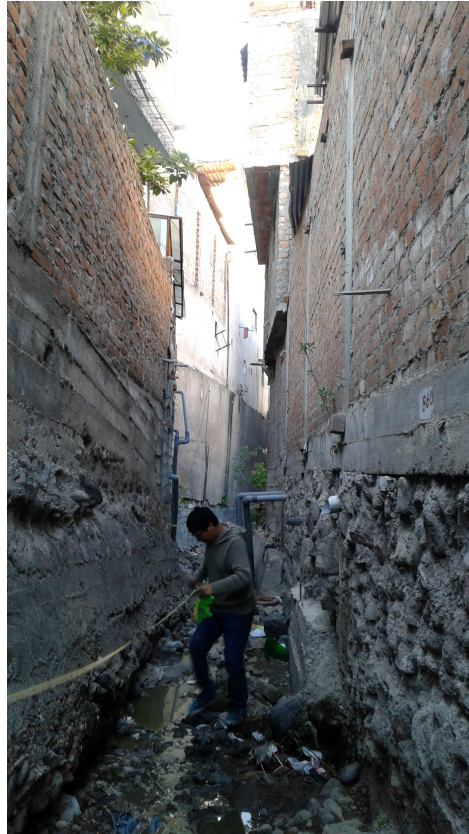
Figura 4.0.1: Nótese el ancho del canal en este tramo solo alcanza el metro
