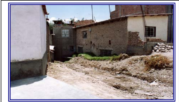
Quebrada Escarcena con cauce estrangulado y sujeta a constantes desbordes
