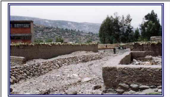
Tramo de la Quebrada ChaquiHuaycco que se encuentra sujeto a inundaciones frecuentes
