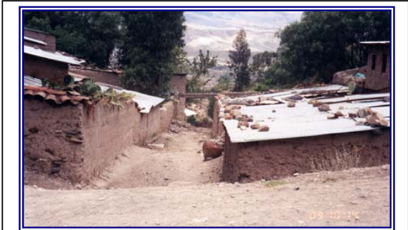
Construcciones sobre el cauce de la quebrada Jr. San Martín cerca de la vía “Los Libertadores”
