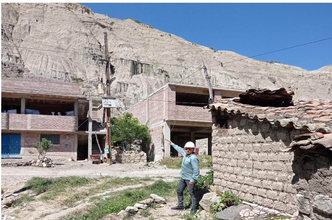
Fotografía 1. Área poblada en peligro por deslizamiento traslacional
