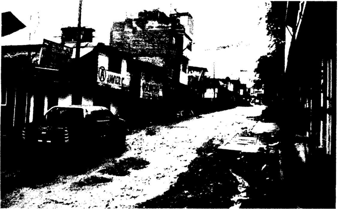
Figura 2.2: Inundación superficial por insuficiencia de la red de drenaje. Fuente: Elaboración propia
