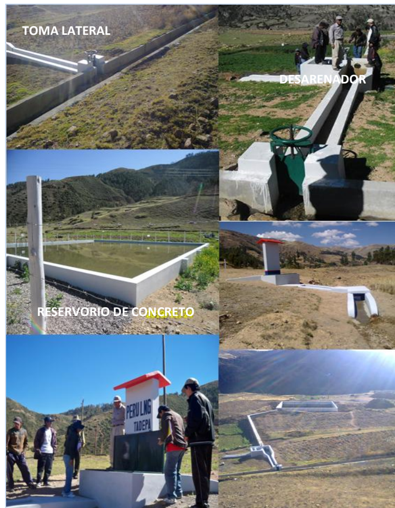
Figura 7. Situación actual de las obras existentes
