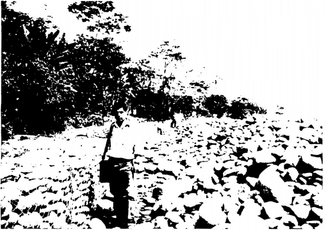
Fotografía N° 11: Inspección del llenado de Gaviones en la margen izquierda del Río Pichari
