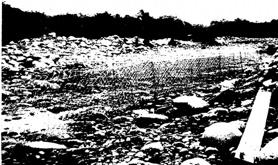
Fotografía N° 09: Tendido de los Gaviones en la margen izquierda del Río Pichari
