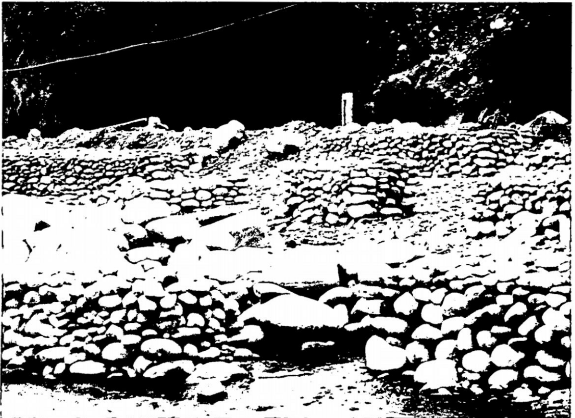
Fotografía N° 08: Acopiamiento de piedras previa selección para la construcción de la defensa ribereña
