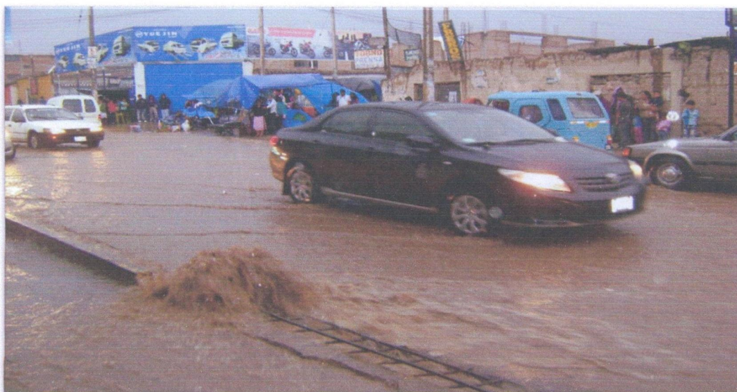
Fotografía N° 05: Los sistemas de drenaje pluvial de las vías principales no son los adecuados y tienden a causar problemas a la población.
