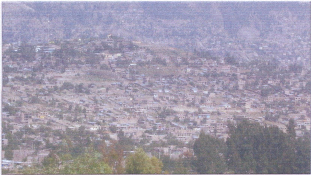
Fotografía N° 02: Vista panorámica del cerro Acuchimay, con características de tener fuertes pendientes.
