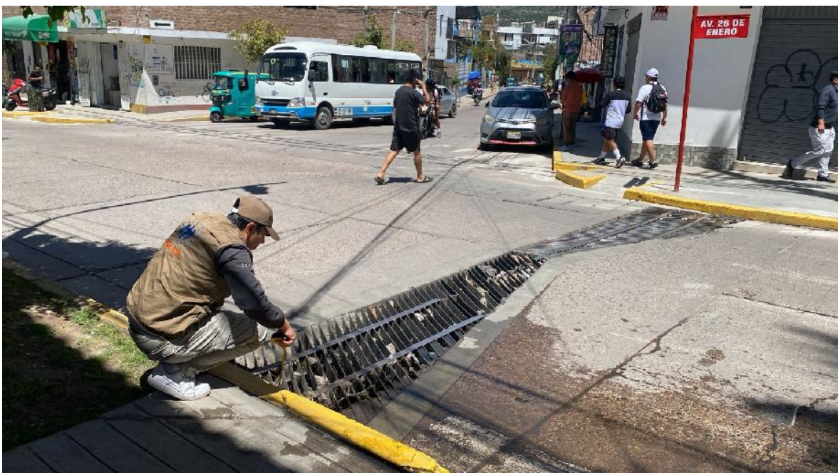
Figura 4.43: Vista panorámica de la identificación de la geometría del modelo a simular
