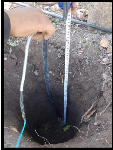
Instalación del Sensor FC-28 a 60 cm de profundidad
