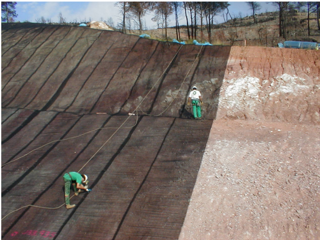
Figura 2.13. Tendido de geomalla
