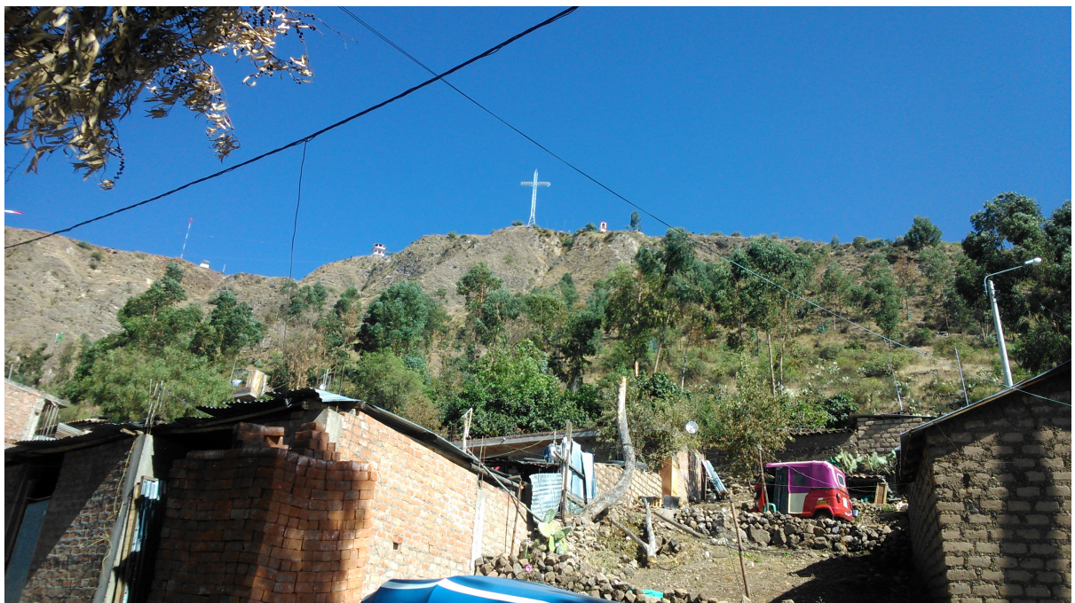
Figura 2.17. Construcción de edificaciones al pie del talud
