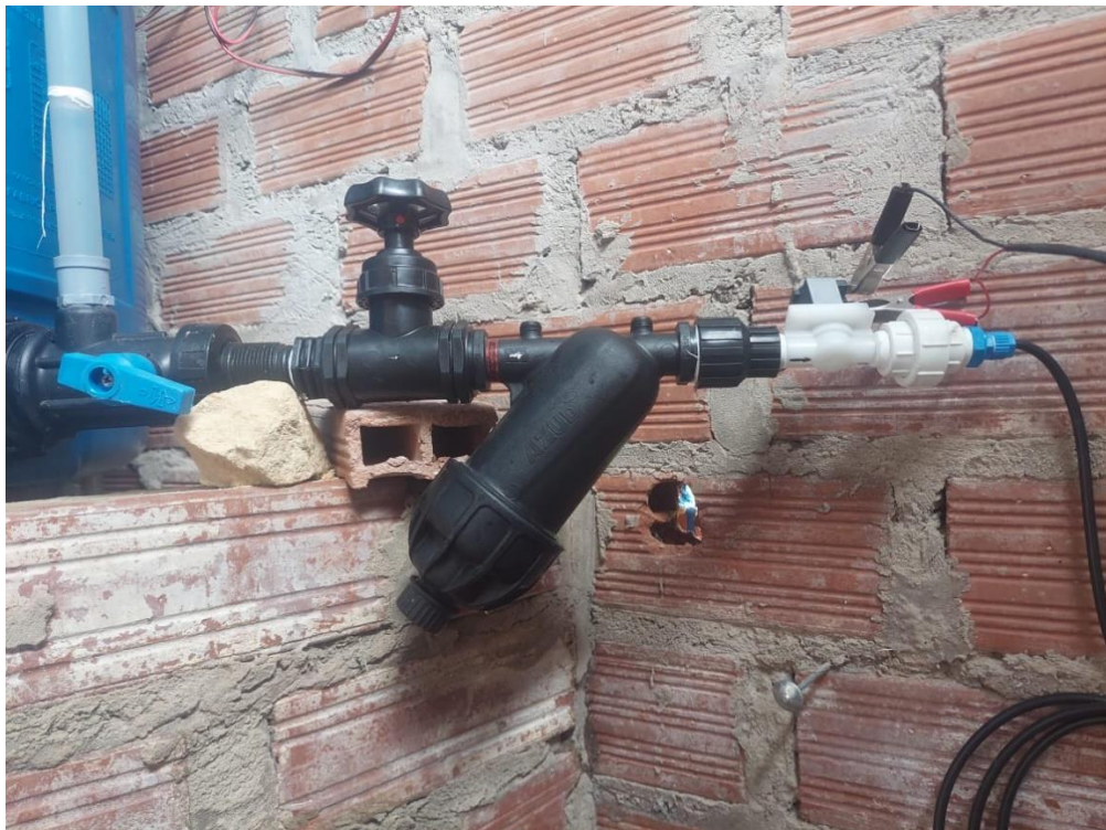
Figura 7.4 Instalación de sistema de cloración automático utilizando Arduino.
