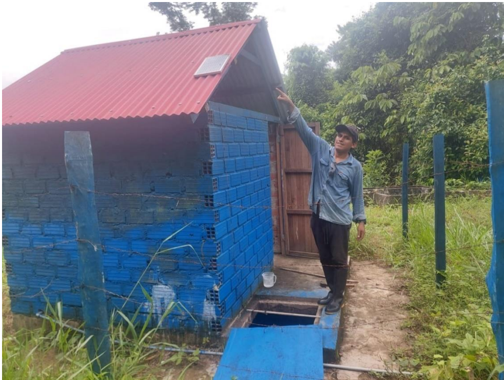
Figura 7.2 Instalación de Panel Solar
