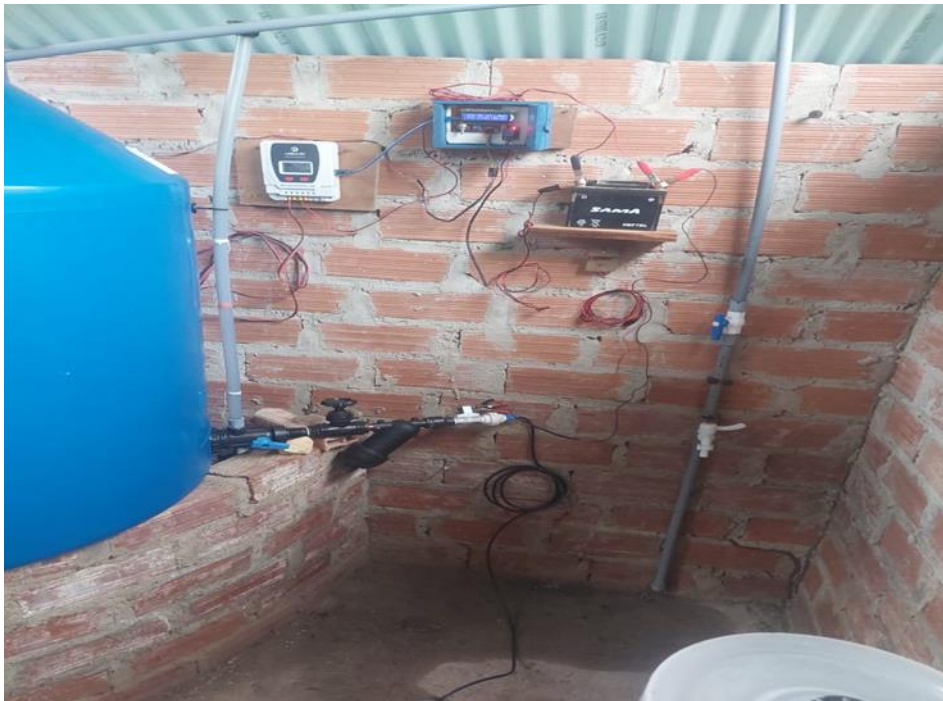
Figura 7.6 Operación de control de caudal automático utilizando Arduino.
