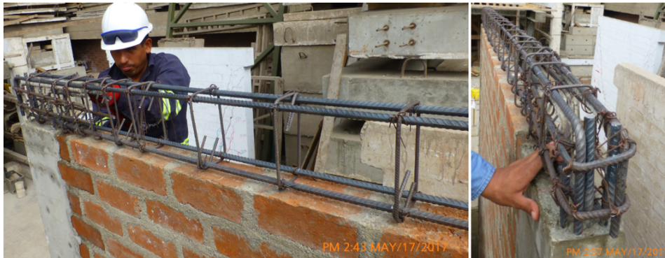
Figura 3.38: Refuerzos en la viga solera.
