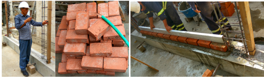
Figura 3.35: Regado, emplantillado y colocación de escantillón de albañilería.
