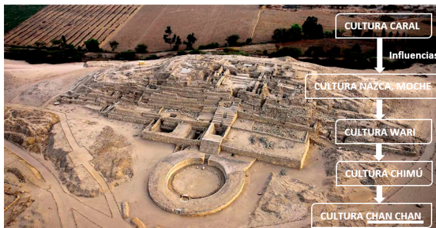
Figura 2.3: Albañilería de tapial - cultura Caral.
