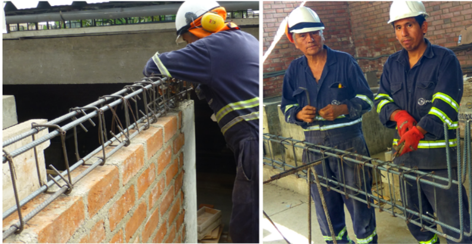
Figura 3.31: Estribos en vigas y columnas.
