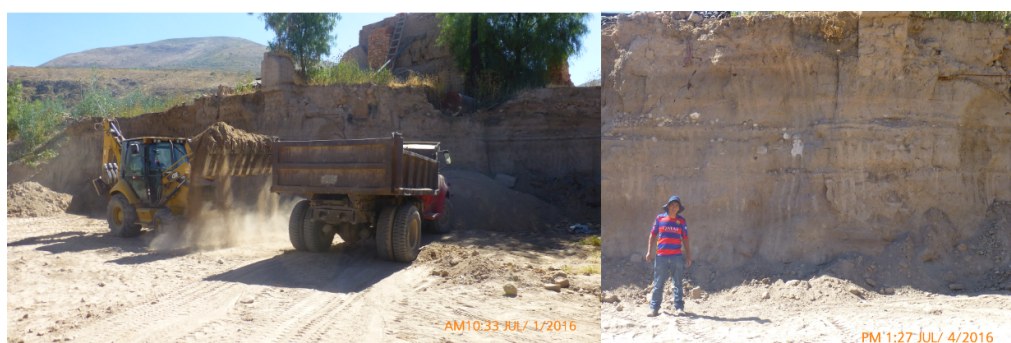
Figura 3.4: Retroexcavadora extrayendo arcilla desde la cantera.
