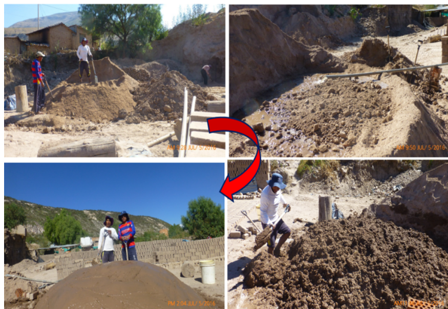
Figura 3.6: Secuencia de mezclado y amasado.
