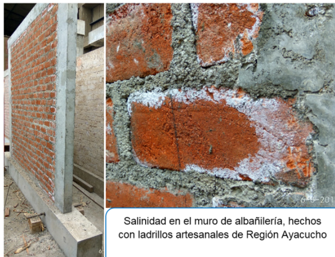
Figura 3.40: Sales solubles en la albañilería artesanal.
