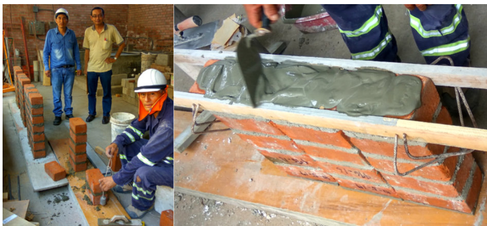
Figura 3.21: Construcción de pilas y aplicación de refrentado (capping).
