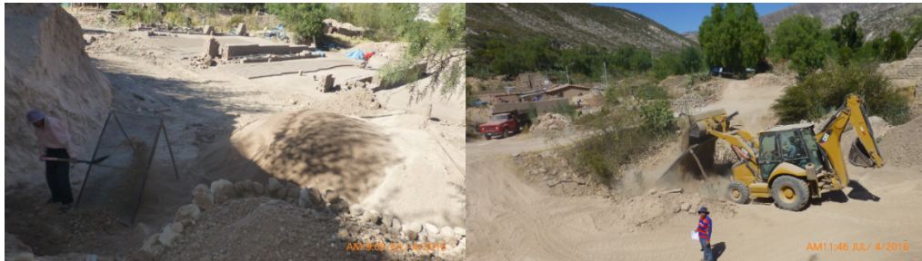
Figura 3.5: Zaranda manual y con retroexcavadora.
