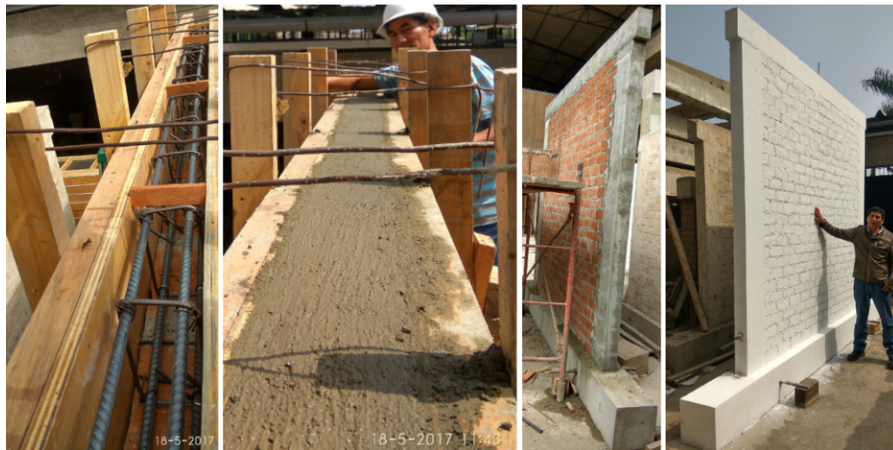
Figura 3.39: Encofrado, vaciado y desencofrado de viga solera.
