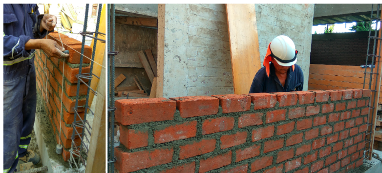
Figura 3.36: Control de verticalidad y primera jornada del muro.
