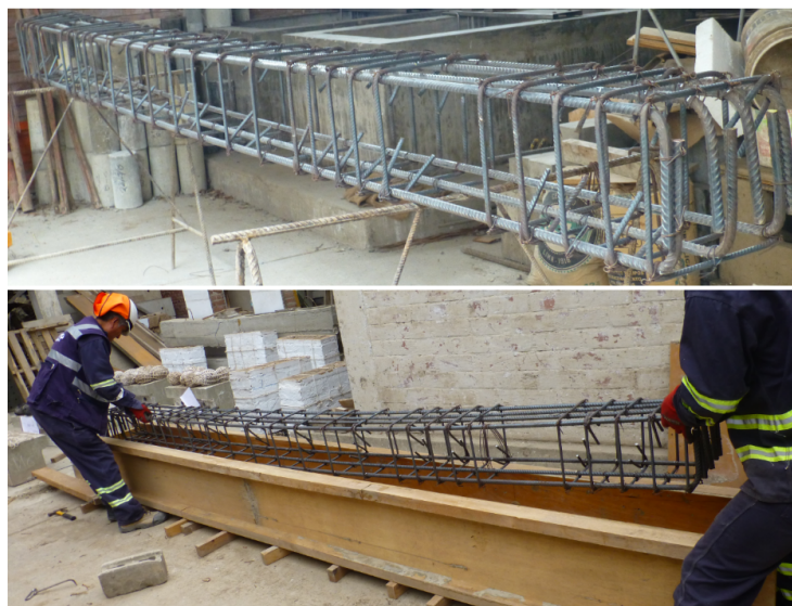
Figura 3.33: Habilidad de encofrado y acero.
