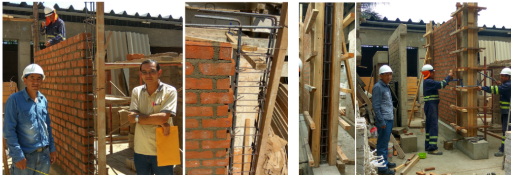
Figura 3.37: Verificación de refuerzos, estribos y encofrado de las columnas.
