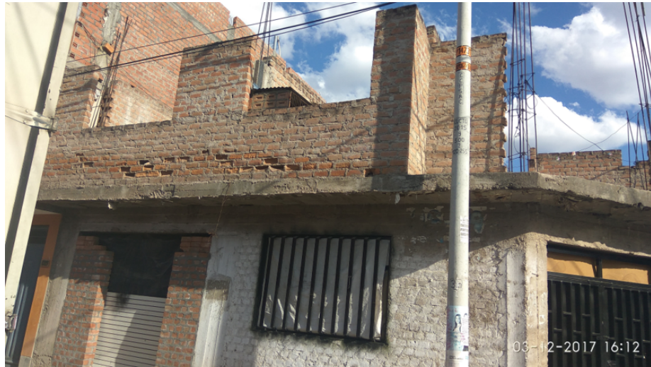
Figura 1.7: Albañilería expuesta a intemperismo sin acabados.
