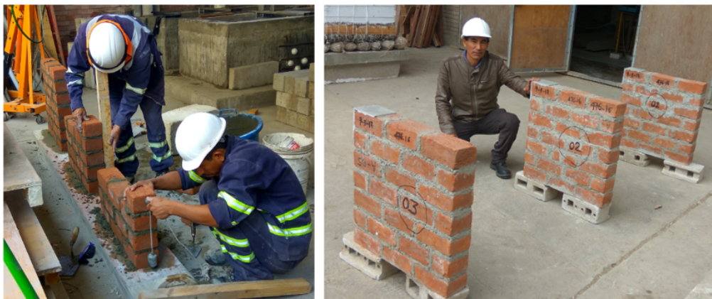
Figura 3.25: Construcción de muretes - murete con capping.
