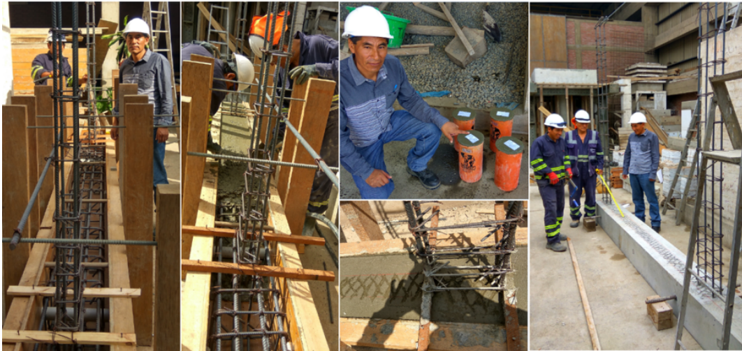
Figura 3.34: Refuerzos verticales, vaciado y desencofrado de cimentación.
