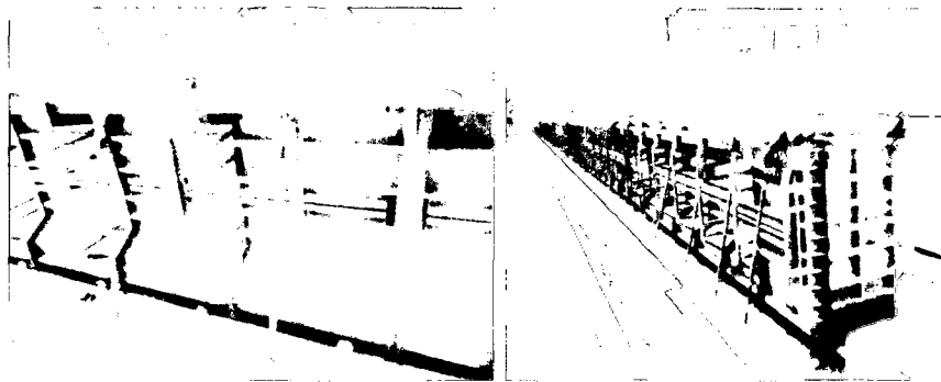
Figura 3.78: Curado de la viga con agua temperada.
