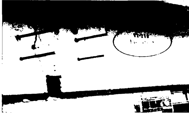
Figura 3.87: Codificación de las vigas.
