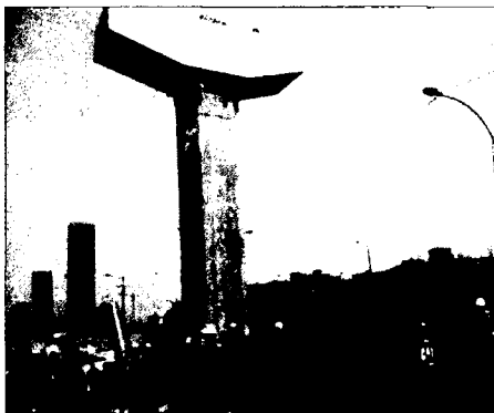
Figura 4.16: Viga cabezal montado en la columna.
