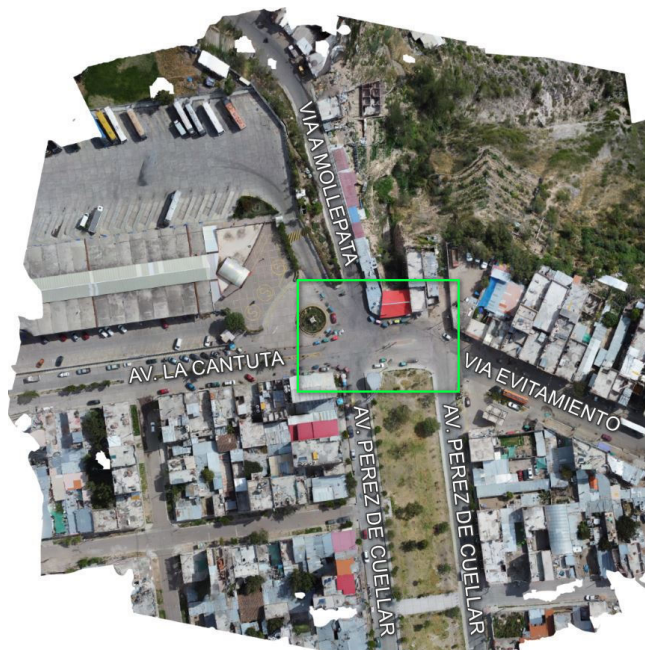
Figura 8: Zona de estudio, intersección frente al terminal terrestre Wari
