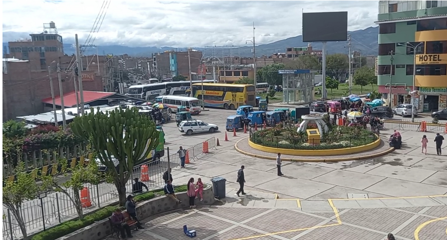
Figura 38: Situación actual de la intersección de estudio
