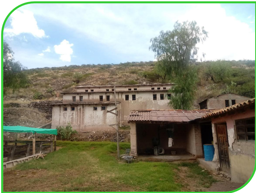
Foto 8. Vista de las condiciones actuales de infraestructura del Centro Experimental Wayllapampa
