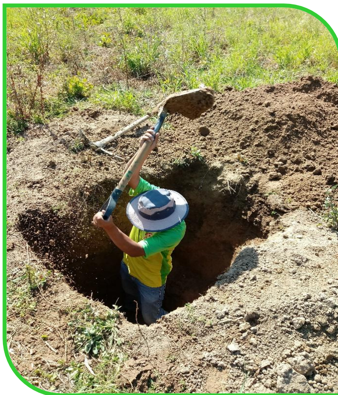
Foto 5. Proceso de apertura de calicatas
