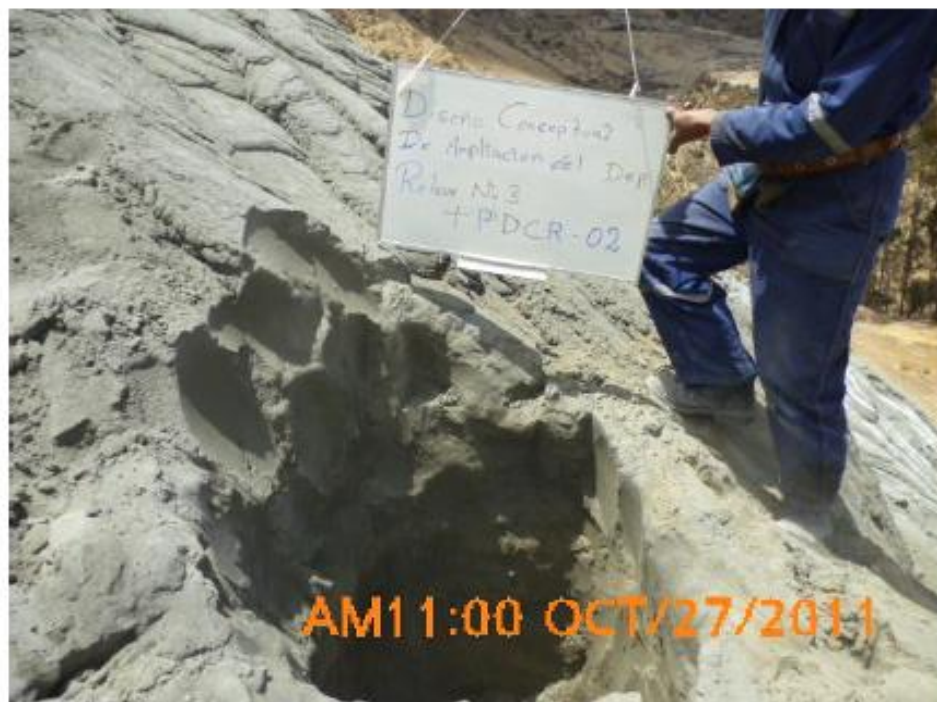
Foto 2 –Vista de la calicata TP-DCR - 02
