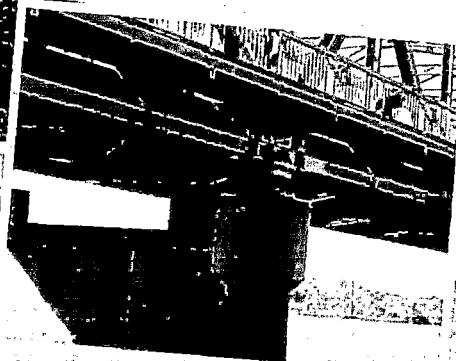
Puente Rio Vista Ubicación típica de un aislador en el reforzamiento del puente Rio Vista en California.
