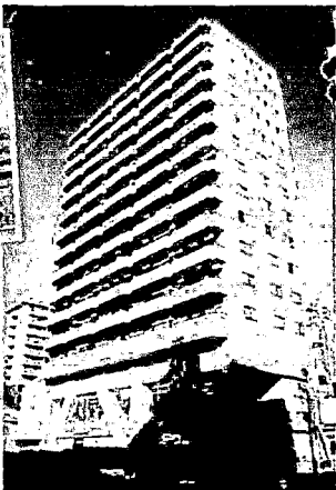
High City Kyosumi utiliza aisladores de 1500mm de diámetro que fueron los más grandes jamás construidos.
