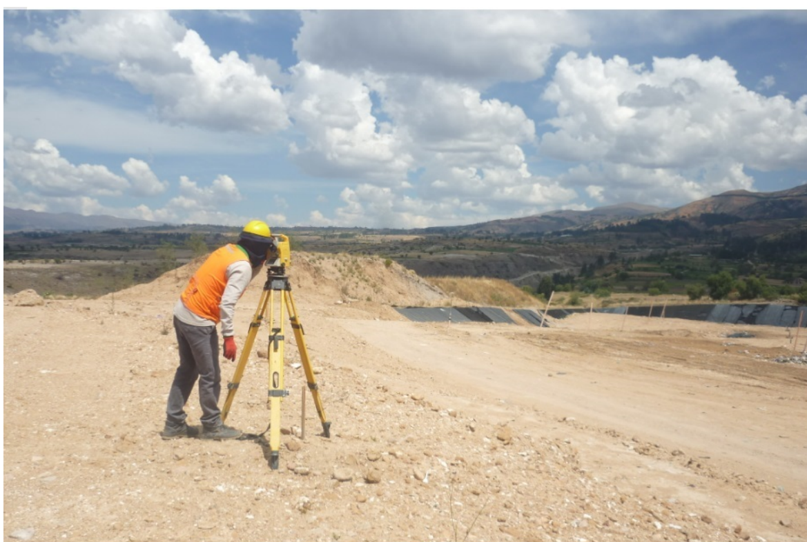
Figura B.6 Trabajos de control topográfico con estación total de las dimensiones de la terraza N°03 Fuente: Elaboración propia
