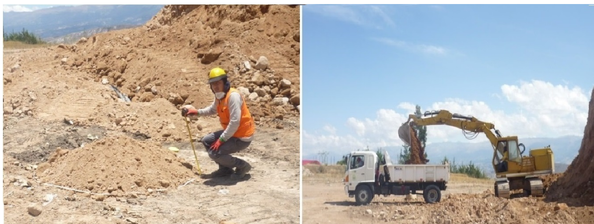
Figura 38 Identificación y transporte de material de cobertura
