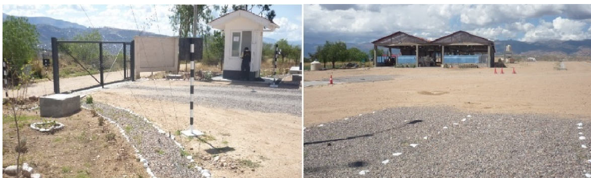
Figura 19 Ingreso principal y vías de acceso interno del relleno sanitario
