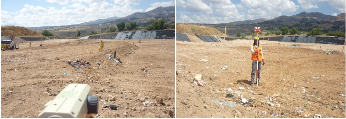
Figura 39 Cobertura y nivelación de la celda diaria.
