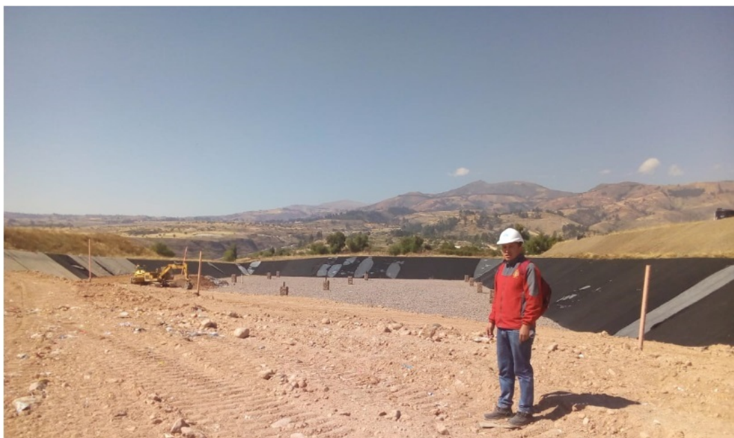
Figura B.3 Trabajos de diagnostico de la infraestructura de la terraza N°03 del relleno sanitario de Huamanga
