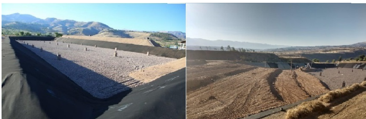
Figura 21 Terraza de disposición final y chimeneas para gases
