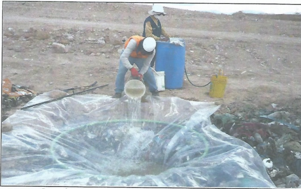
Fotografía N°05. Cubierta con plástico sobre el anillo metalico de control.
