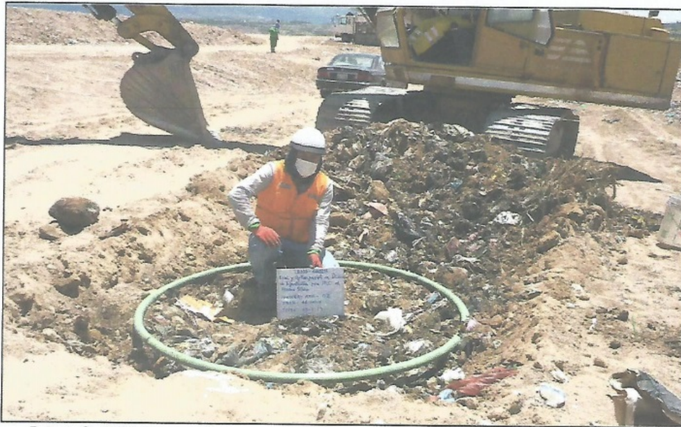
Fotografía N°01. Excavación con maquinaria para extracción de material de residuos solidos.
