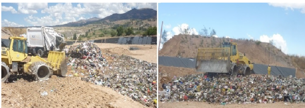
Figura 26 Compactación de residuos sólidos
