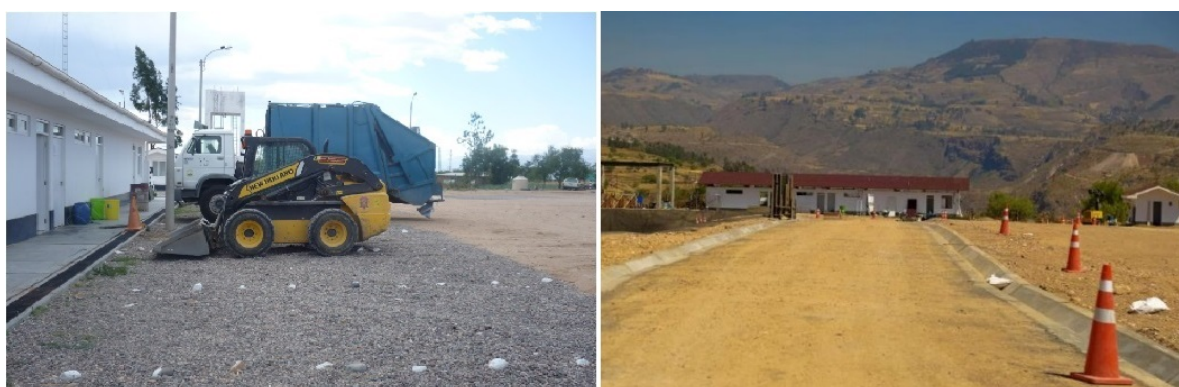
Figura 20 Infraestructuras administrativas y de servicio del relleno sanitario
