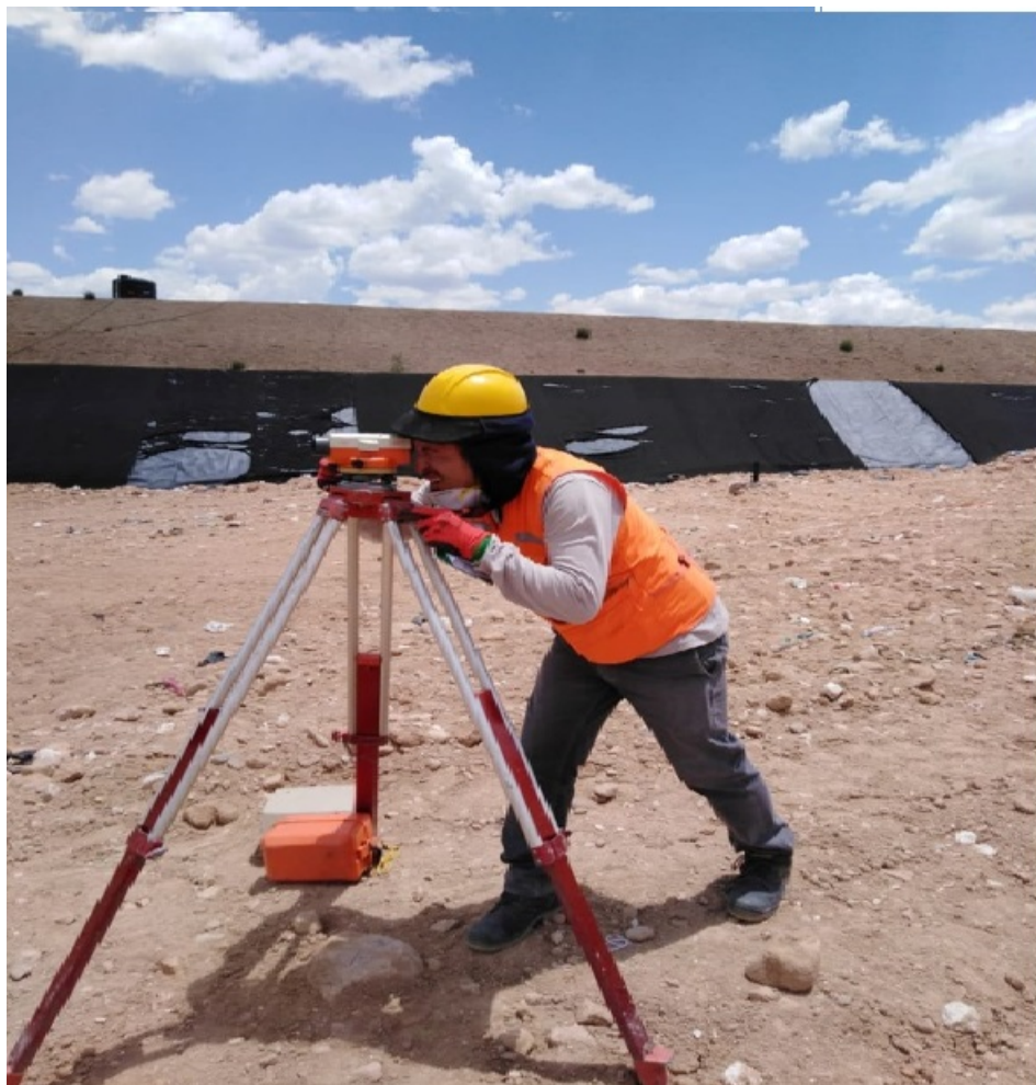
Figura B.2 Trabajos de nivelación de superficies para conformación de celda diaria Fuente: Elaboración propia
