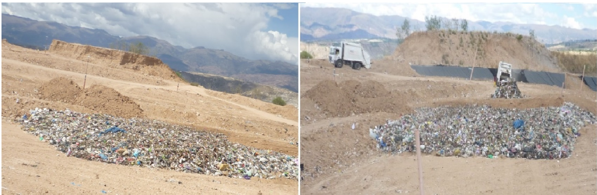
Figura 37 Relleno con residuos en la conformación de la celda diaria.
