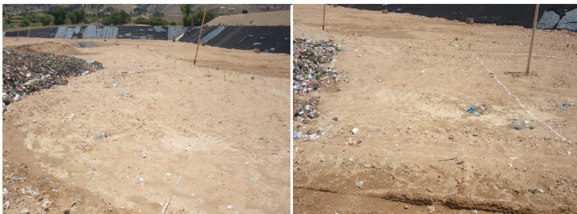
Figura 34 Medición y trazo de la celda diaria.
