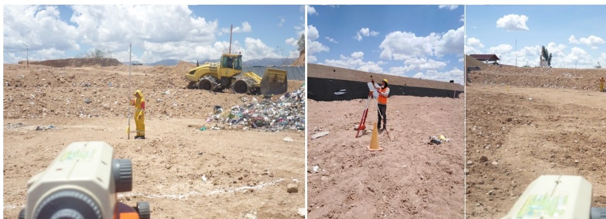
Figura 35 Marcación y nivelación de la celda diaria.
