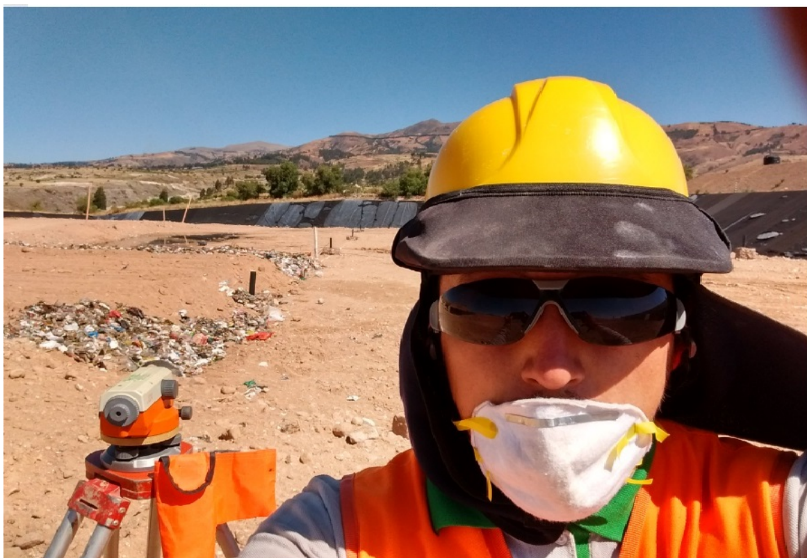
Figura B.5 Trabajos de control topográfico con nivel de ingeniero en conformación de celda diaria Fuente: Elaboración propia
