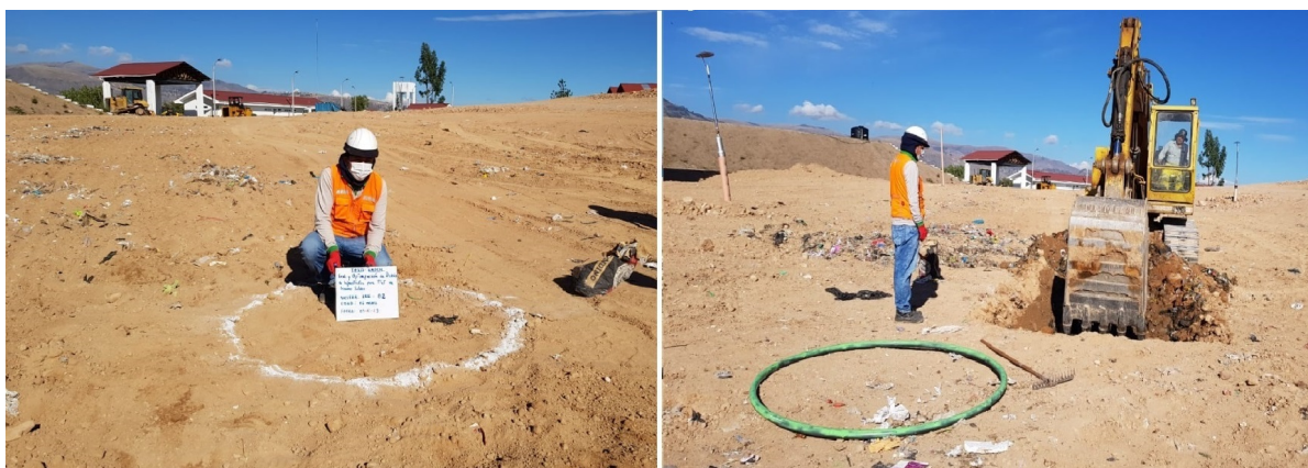
Figura 41 Marcación y retiro de material de cobertura
