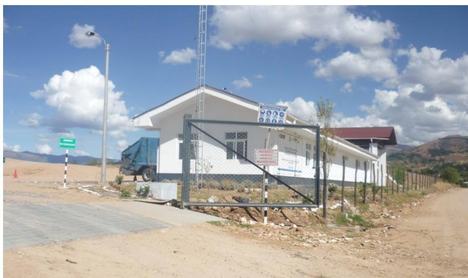
Figura 8 Acceso al relleno sanitario de Huamanga
