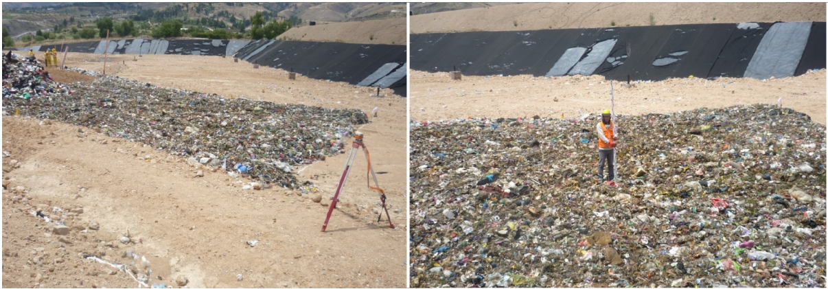
Figura 36 Trabajos de confinamiento de residuos sólidos en la celda diaria.
