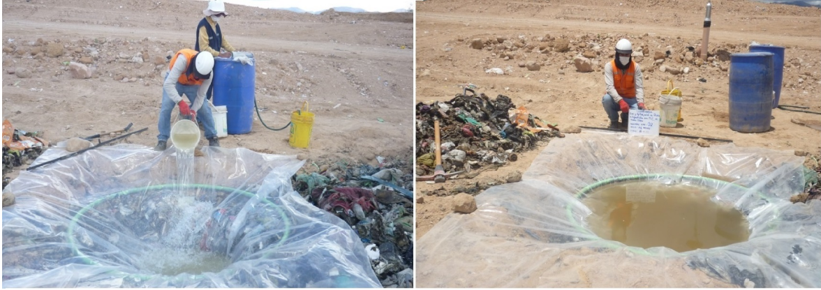
Figura 46 Volumen de los residuos sólidos estabilizados
