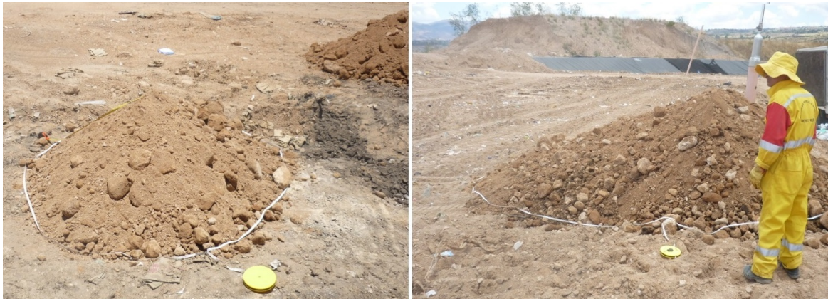
Figura 40 Cubicación y tipo de material de cobertura
