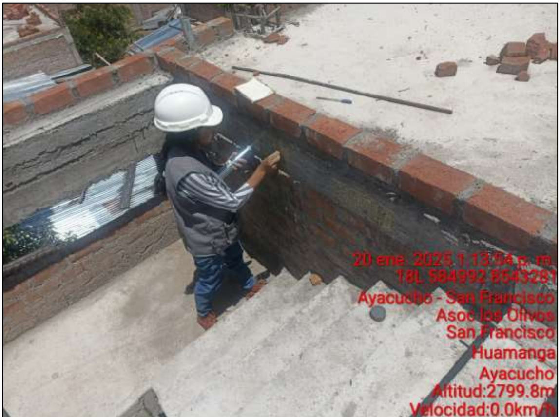
Ensayo esclerómetro en losa aligerada
