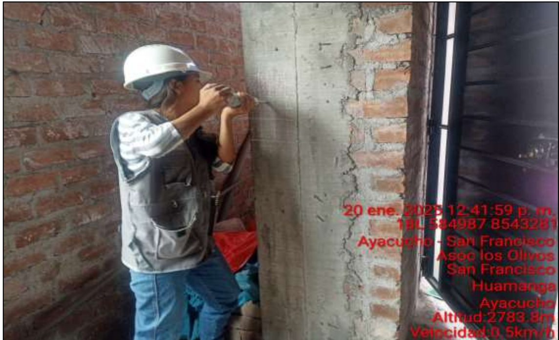
Ensayo con esclerómetro en columna
