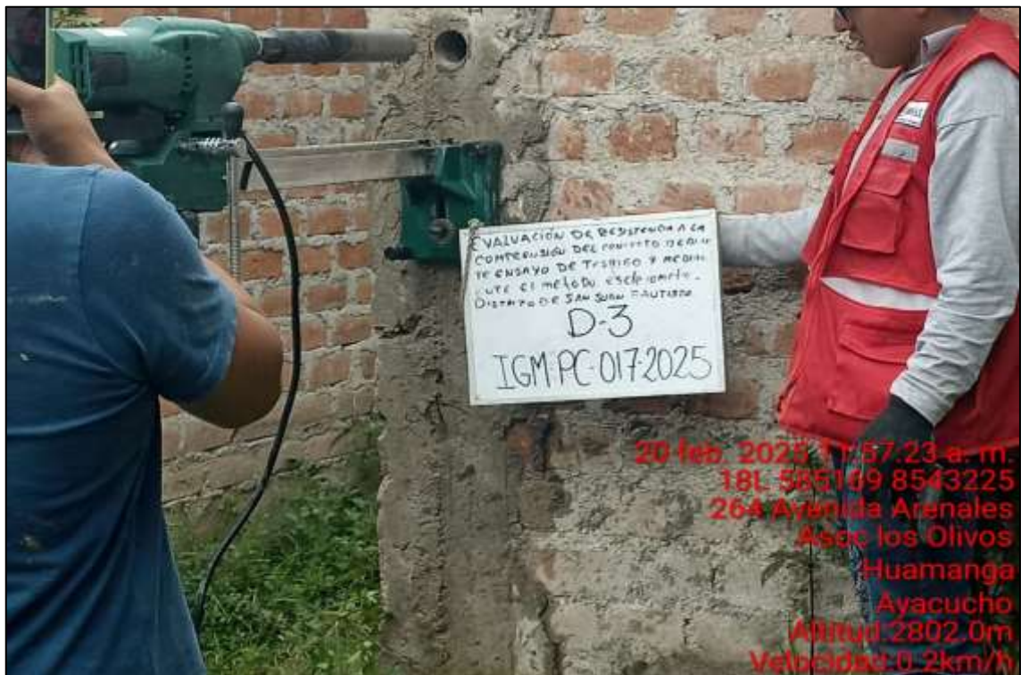
Extracción de núcleo diamantino en columna
