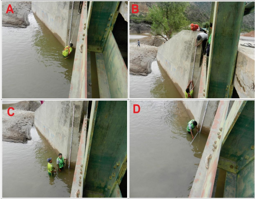
Figura 65: Proceso de instalación de la escala limnimétrica para el monitoreo de descargas líquidas
