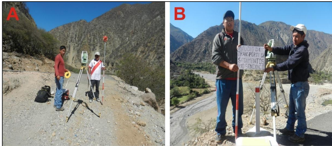
Figura 59: Levantamiento topográfico para la caracterización geomorfológica del cauce
