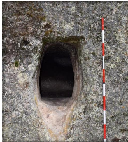
Figura:24: zona de acceso.
