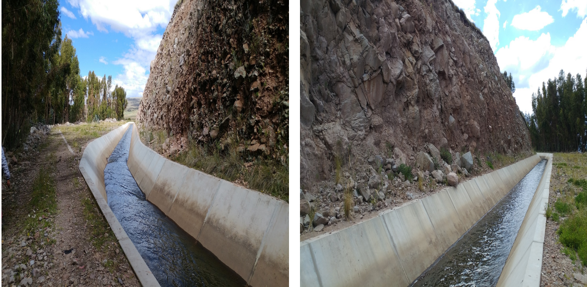
(a) Vista aguas arriba del tramo de estudio.
