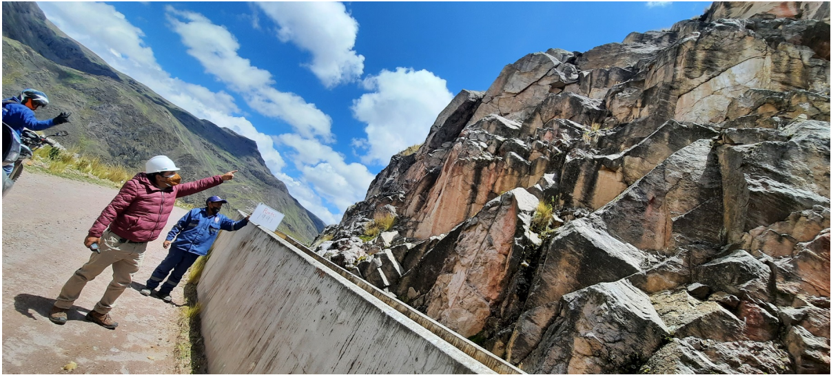
Figura 46 Punto 21 zona de riesgo tramo: Apacheta - Choccoro en el Canal del ex PERC.
