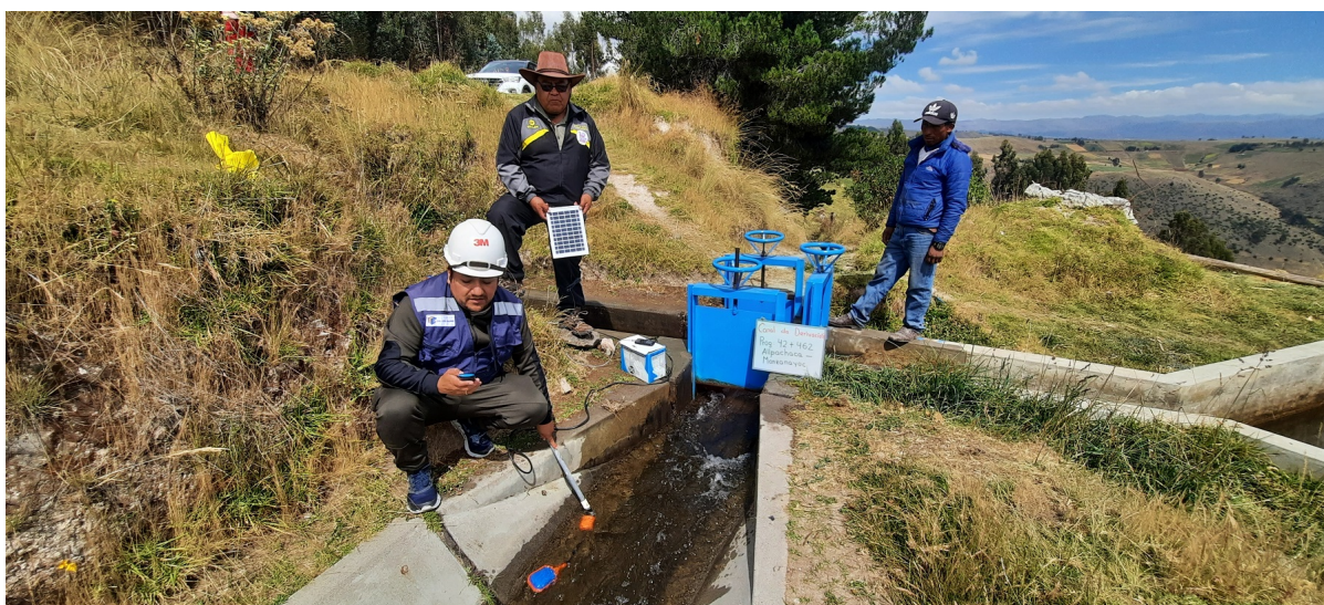
Figura 106 Inicio de la prueba en el canal de derivación. Fuente: Elaboración propia
