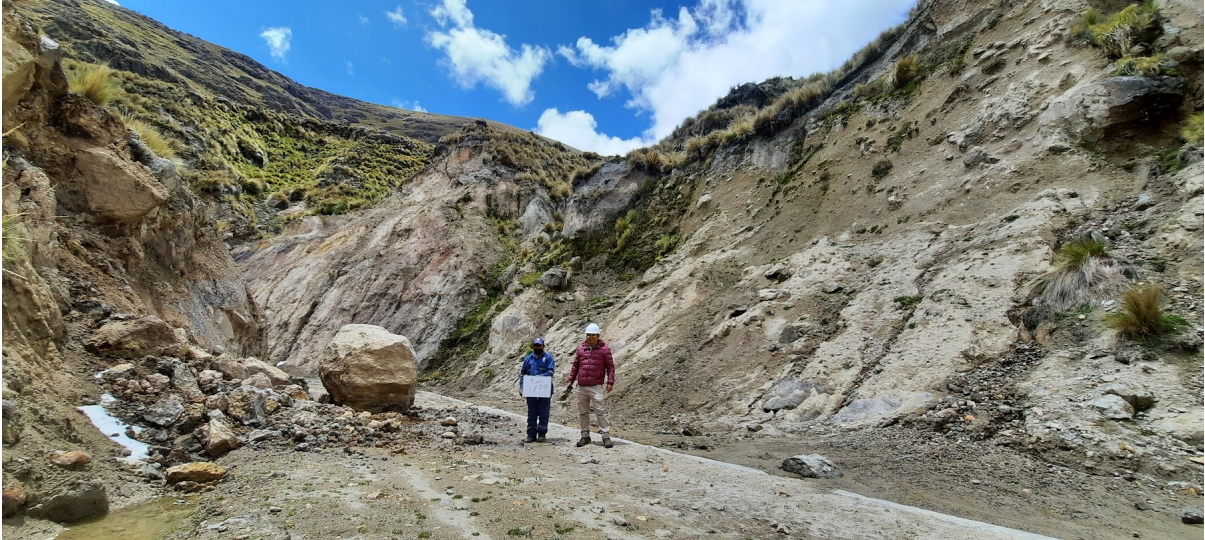
Figura 38 Punto 13 zona de riesgo tramo: Apacheta - Choccoro en el Canal del ex PERC.
