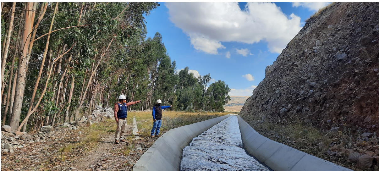
Figura 79 Punto 46 zona de riesgo tramo: Apacheta - Choccoro en el Canal del ex PERC.
