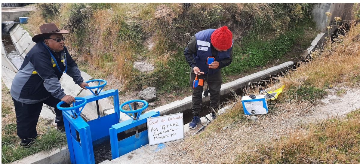
Figura 101 Canal de derivación Km 42+462 en el canal del ex proyecto Río Cachi. Fuente: Elaboración propia
