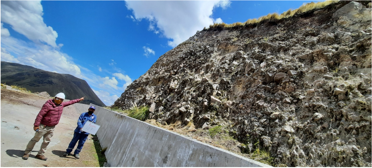
Figura 62 Punto 37 zona de riesgo tramo: Apacheta - Choccoro en el Canal del ex PERC.
