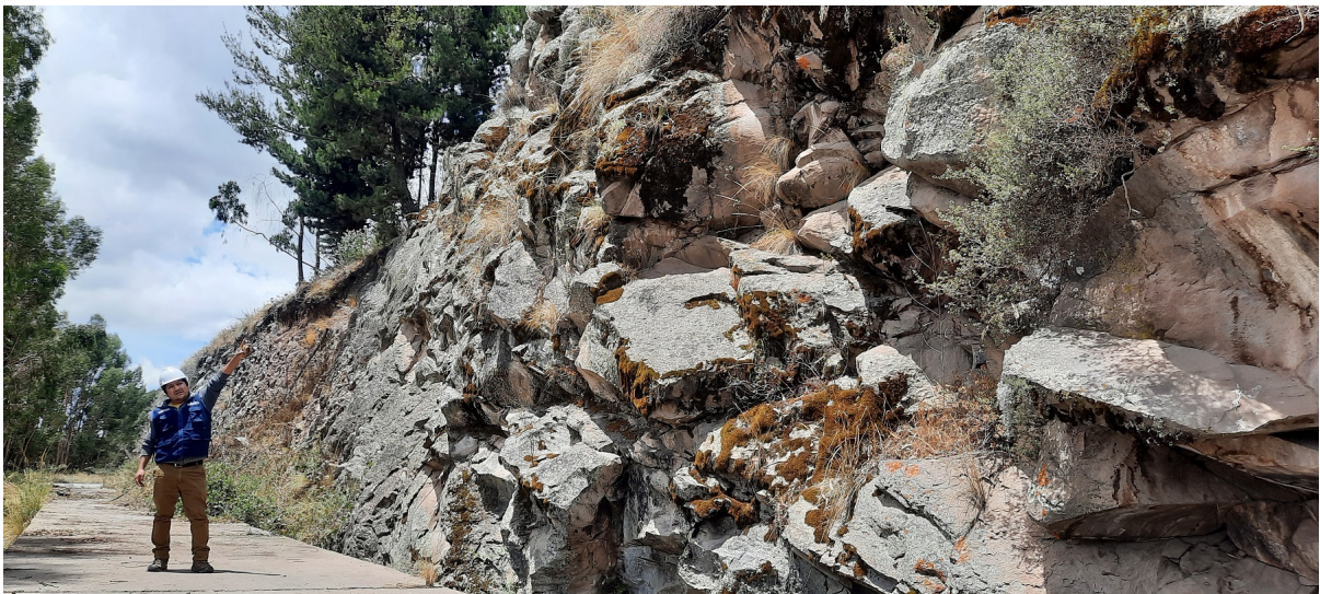
Figura 71 Punto : 43: Munaypata - Satica en el Canal del ex PERC.
