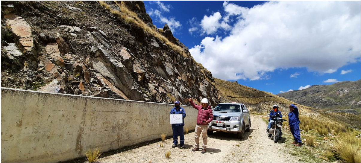
Figura 30 Punto 05 de la zona de riesgo tramo: Apacheta - Choccoro en el Canal del ex PERC.
