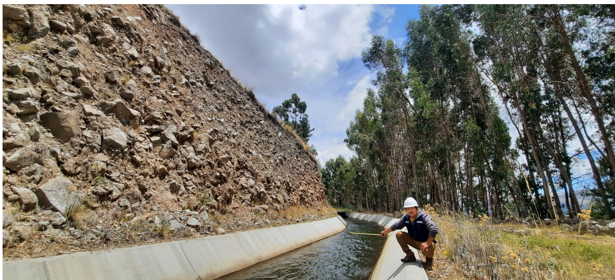
Figura 74 Punto : 46: Munaypata - Satica en el Canal del ex PERC.
