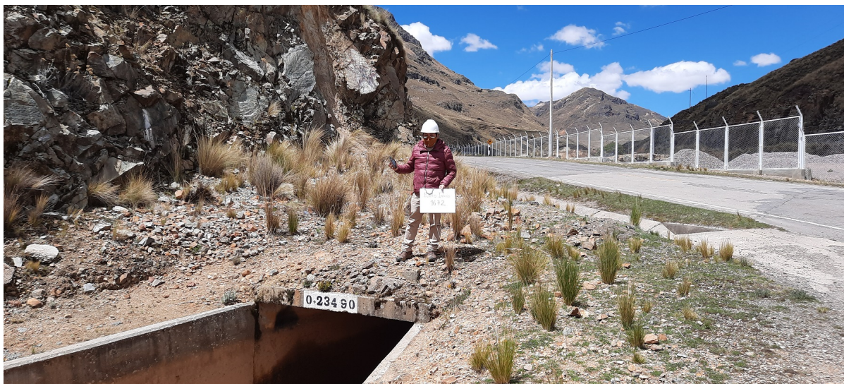
Figura 25 Inicio del tramo: Apacheta - Choccoro en el canal del ex PERC.
