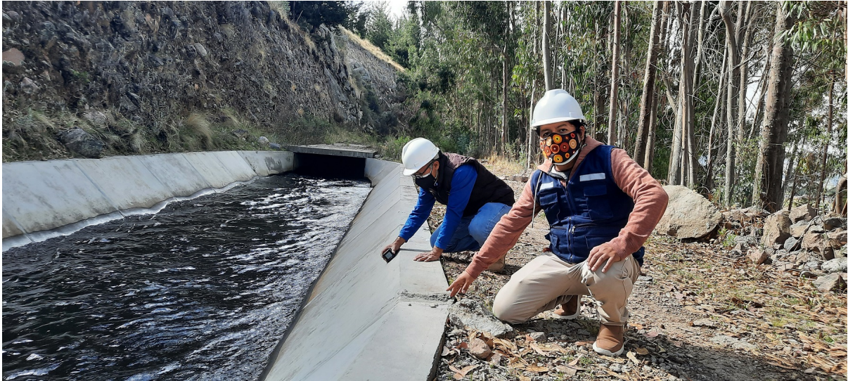
Figura 78 Punto 46 zona de riesgo en Satica KM 17+370, en el Canal del ex PERC.
