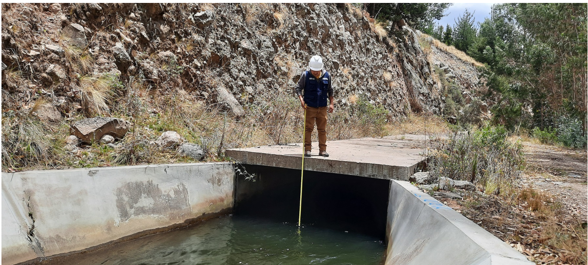
Figura 73 Punto : 45: Munaypata - Satica en el Canal del ex PERC.
