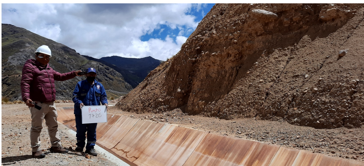
Figura 27 Punto 02 de la zona de riesgo tramo: Apacheta - Choccoro en el canal del ex PERC. Fuente: Elaboración Propia
