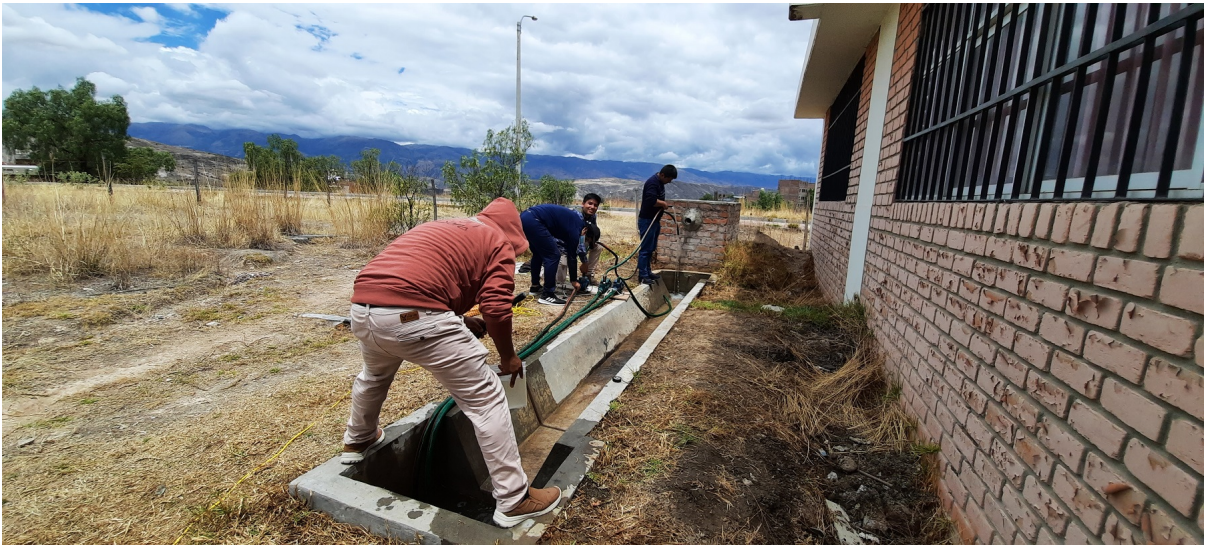
Figura 87 llenando de agua las posas en el laboratorio Hidráulico
