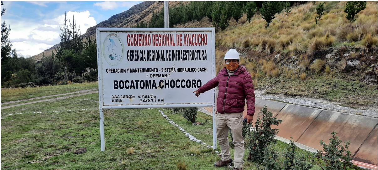
Figura 67 Bocatoma Choccoro en el Canal del ex PERC.
