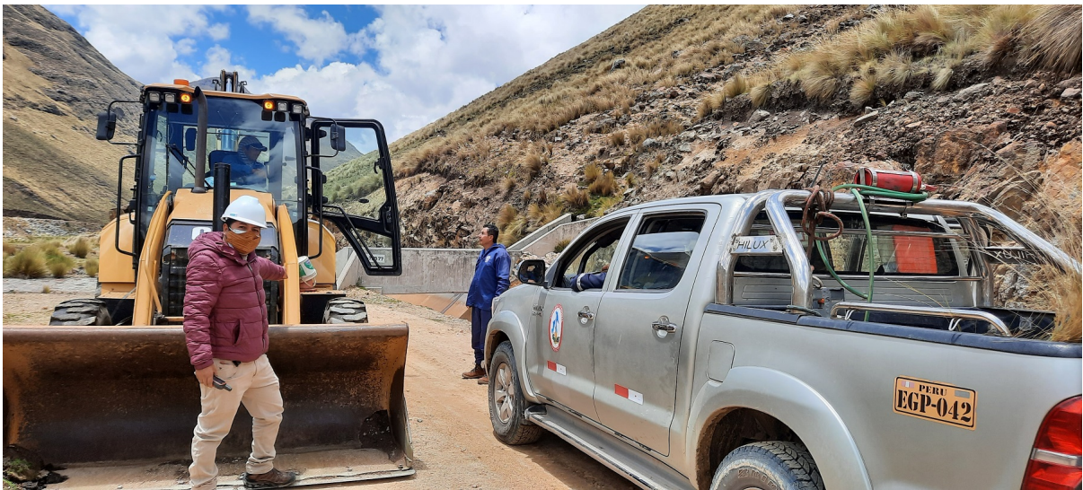
Figura 40 Punto 15 zona de riesgo tramo: Apacheta - Choccoro en el Canal del ex PERC.
