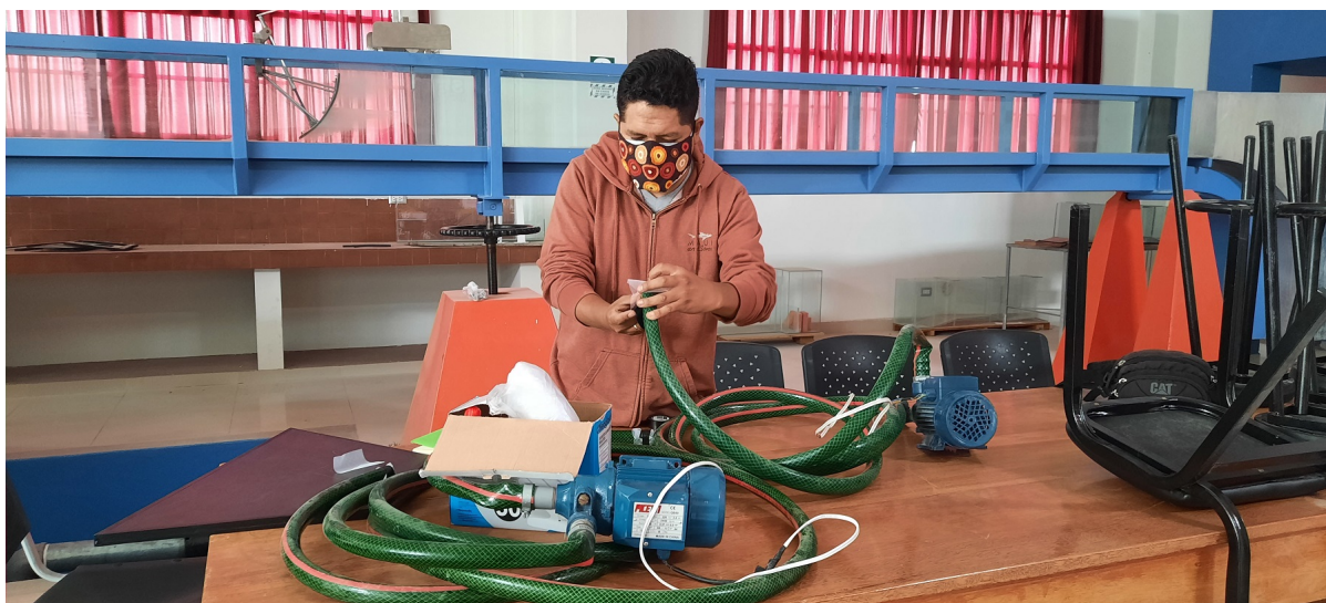
Figura 17 Revisión de las bombas hidráulicas.
