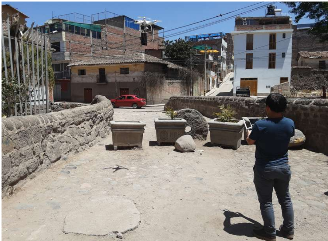
Figura 3.11: Toma de datos con el drone en el puente San Sebastian.
