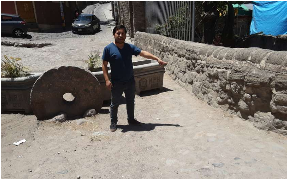
Figura 3.5: Daños estructurales en el puente San Sebastian.
