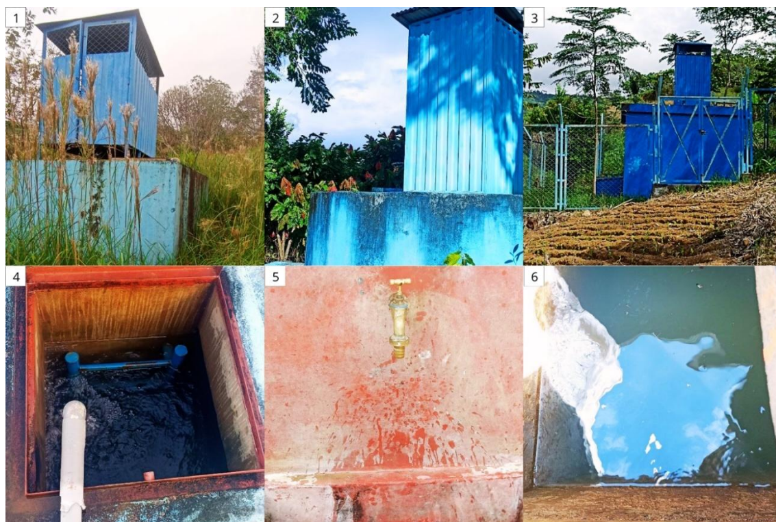
(1) Reservorio de Buenos Aires (2) Reservorio de Monterrico (3) Reservorio de San Agustín (4) Reservorio de Villa Rica (5) Grifo domiciliario de Villa Rica (6) Almacenamiento de agua del reservorio de Buenos Aires.
