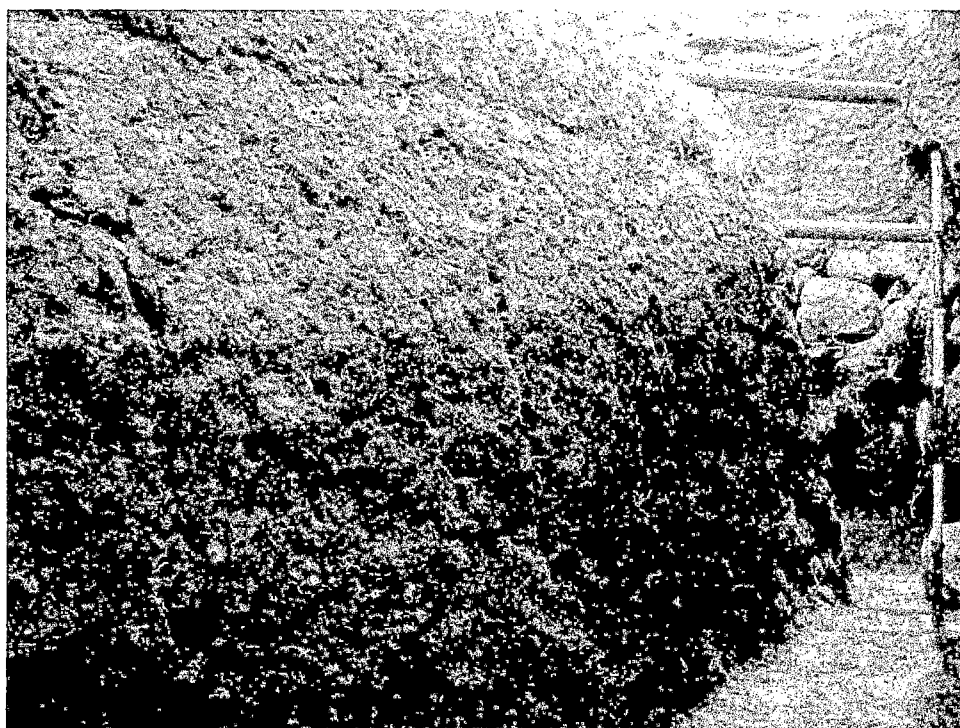
Figura 62: Foto A enlucido en la arquitectura de adobe en la unidad 2, con el enlucido de color naranja rojizo. Foto B enlucido en la arquitectura de adobe en la unidad 4, donde se observa el deterioro por la humedad.
