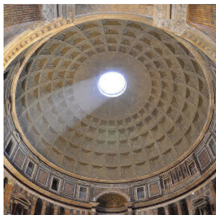
Figura 2.1. Panteón con su bóveda de 43.20 m. Roma
