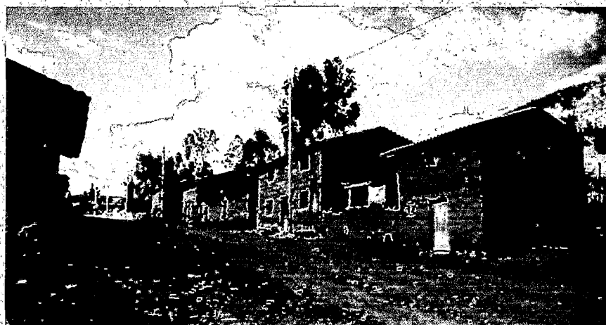
Figura N° 05: Típica vivienda de adobe en el Perú.
