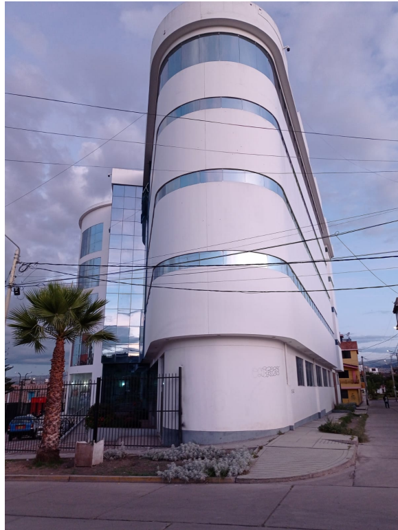
Figura 3.2: Fotografía Nro 02 del edificio de Archivo Regional de Ayacucho.
