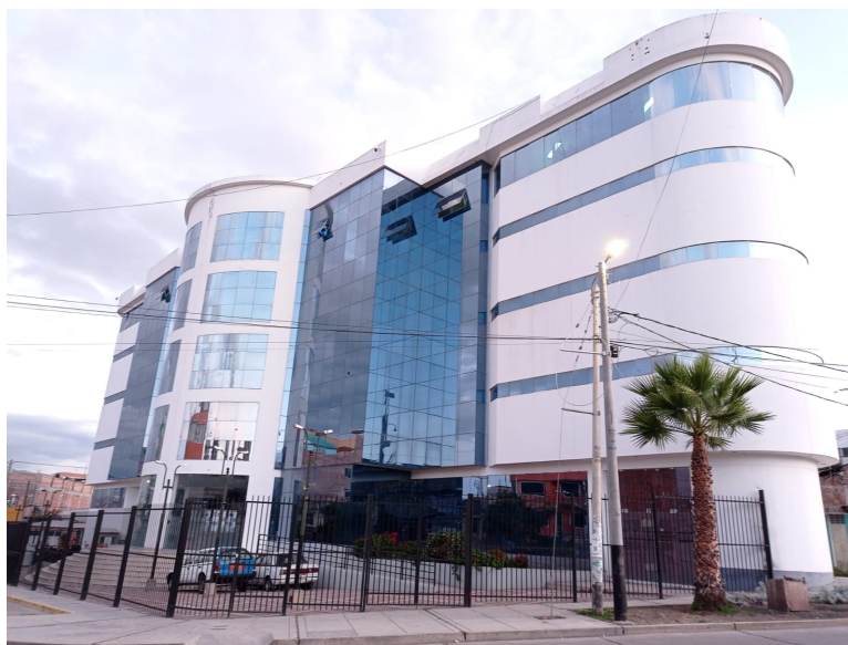
Figura 3.1: Fotografía Nro 01 del edificio de Archivo Regional de Ayacucho.
