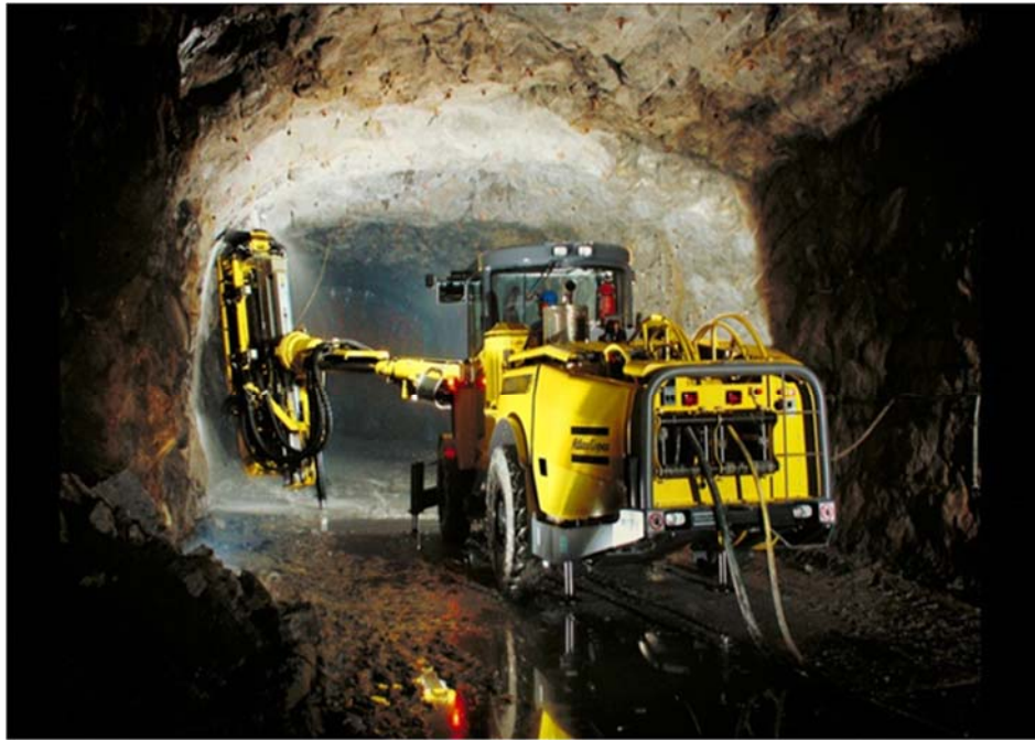
Foto N° 08 Perforación de Taladros Largos
