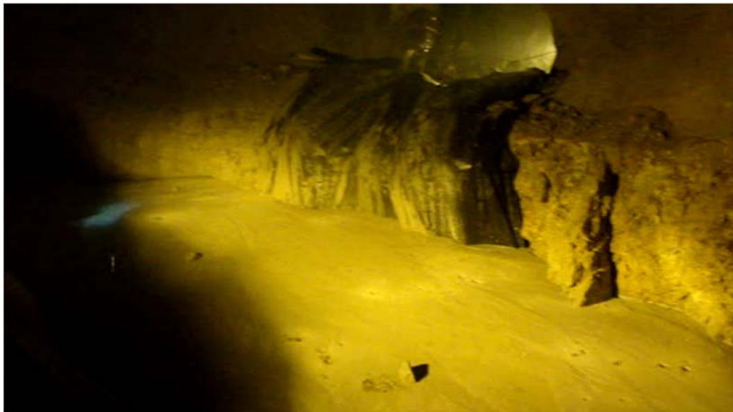
Foto N° 07 Tajeo en Proceso de Relleno en Pasta (SARC)
