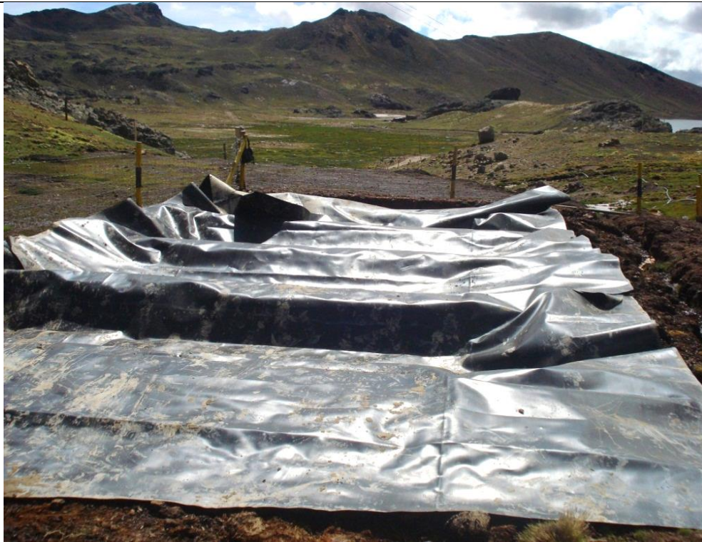
Fotografía 05. Impermeabilización de las pozas con geomembrana de HDPE.
