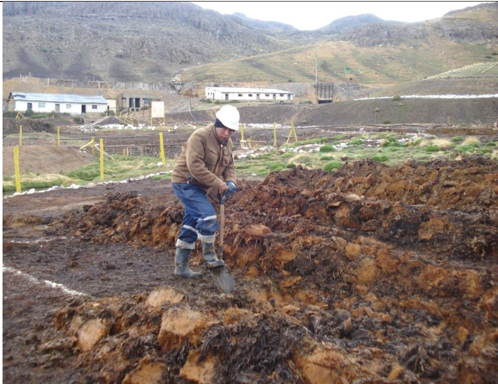
Fotografía 03. Tesista realizando la excavación de las pozas a fin de aplicar el tratamiento de aguas de la mina Pampamachay.
