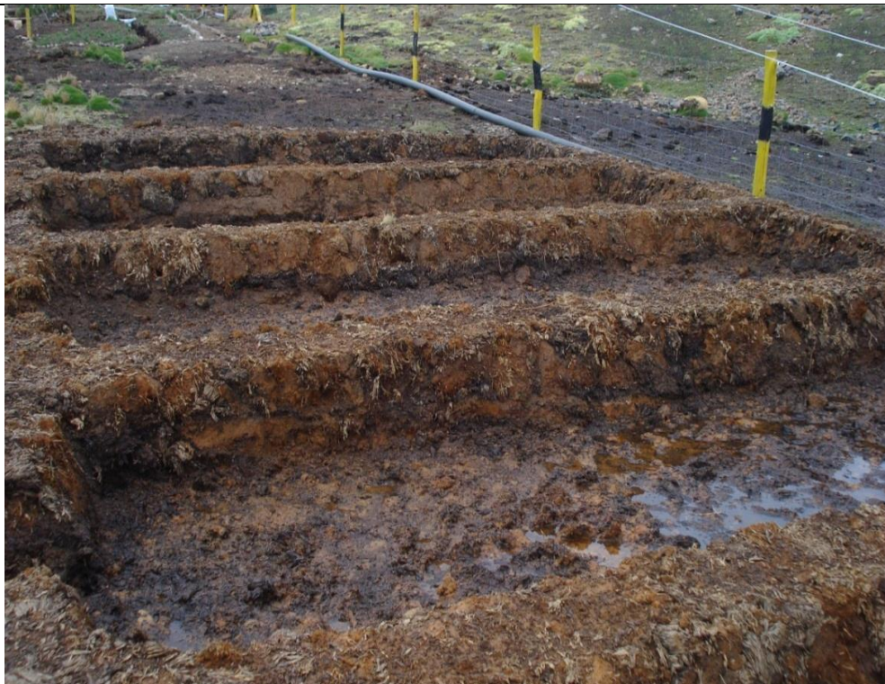
Fotografía 04. Pozas excavadas sobre terreno.
