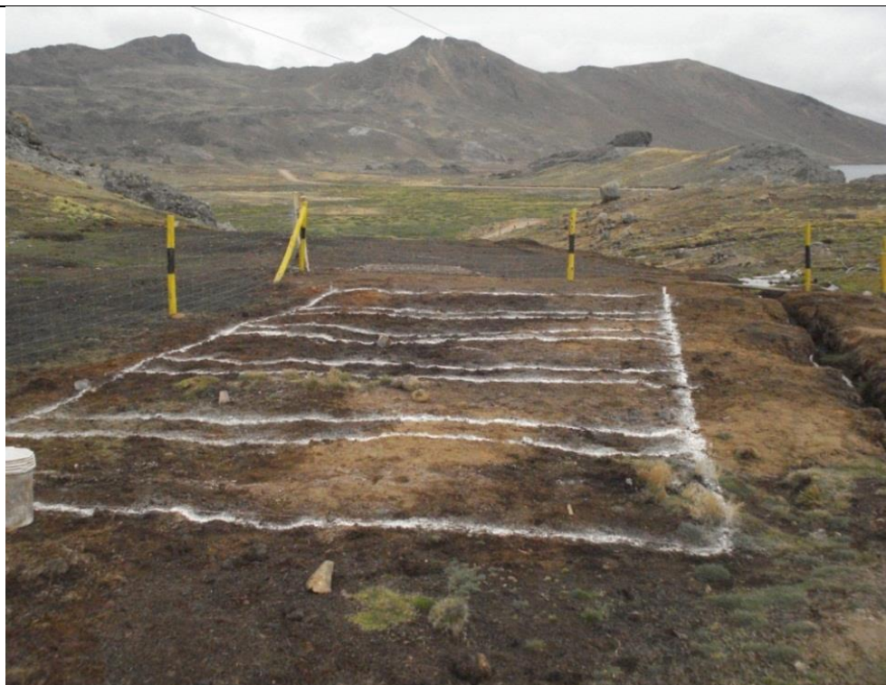
Fotografía 02. Delimitación del área para la excavación del terreno y la instalación de las pozas de tratamiento.
