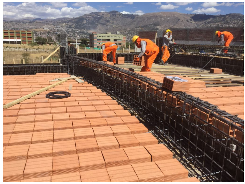
Figura C.2: Colocado de ladrillo de techo y colocado de acero en viga curva
