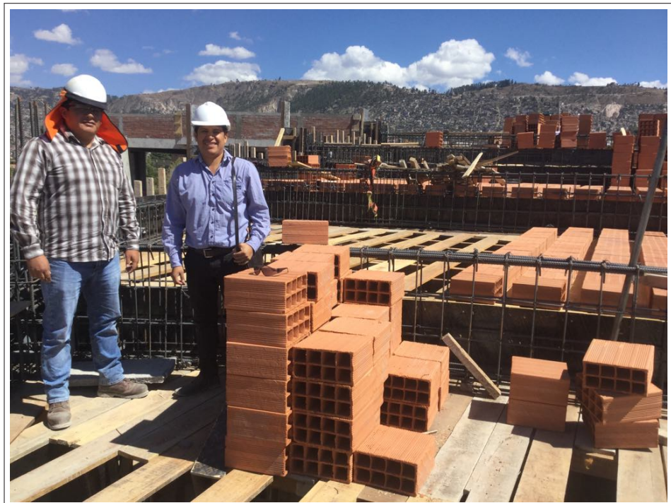
Figura C.5: Visita a obra gracias al contratista CONSORCIO LIGEM
