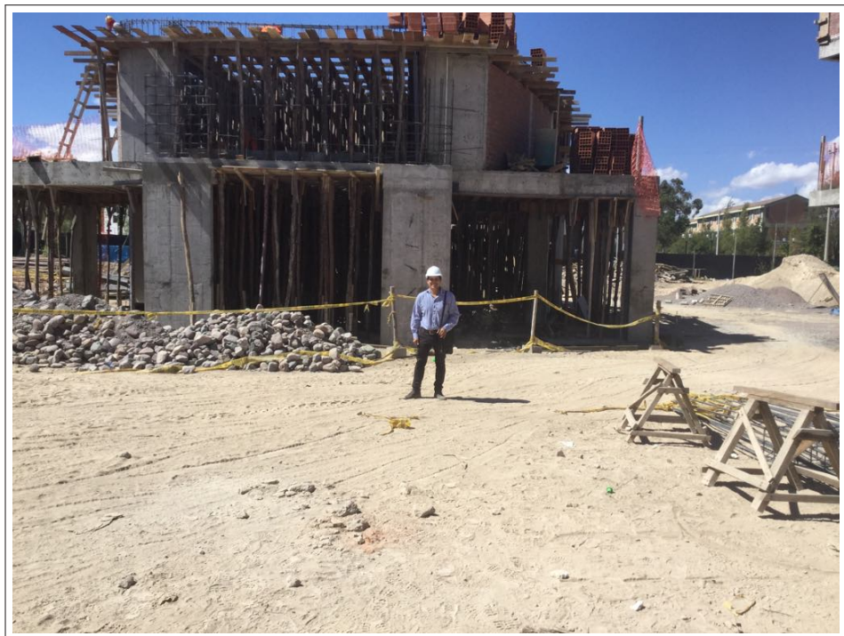
Figura C.1: Vista del ingreso al módulo 2 Fuente: Elaboración propia
